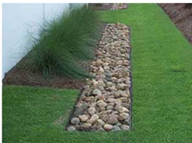
Aspecte d'un exemple de rasa d'infiltració
