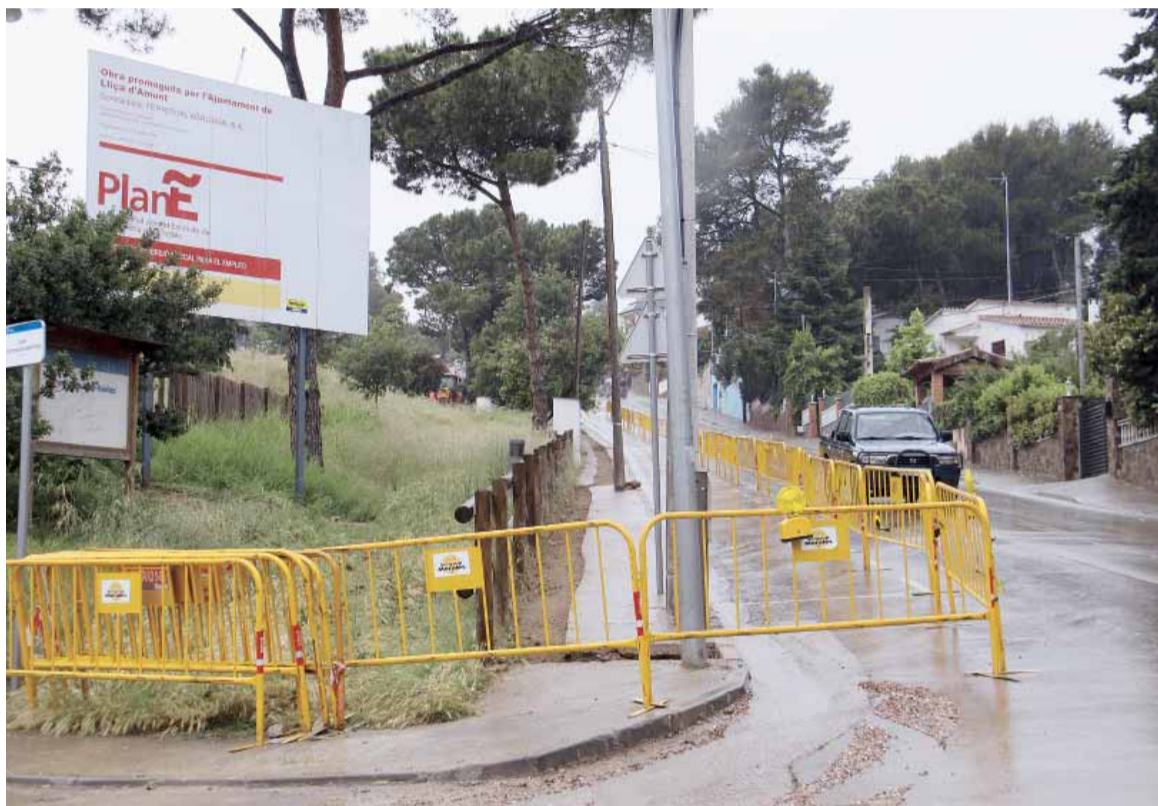
OBRES AL CARRER DE RAMON LLULL
