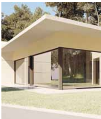
IMATGES DEL PROJECTE
