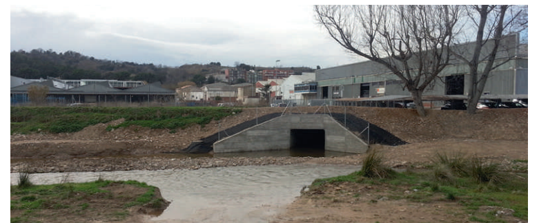
Un dels calaixos que funciona com a tanc de tempesta
