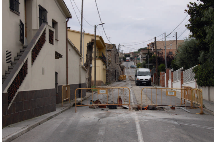
Segona fase de les obres
