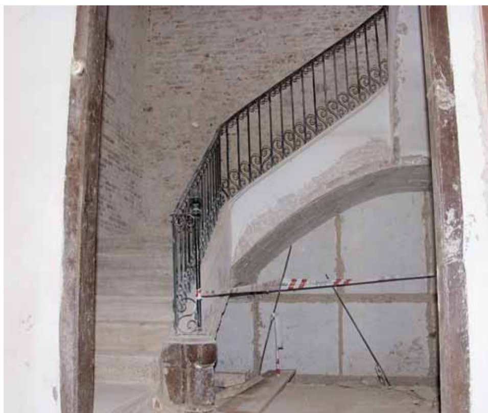
DETALL DE L'INTERIOR DE L'EDIFICI DE LA MASIA QUE S'ESTÀ RESTAURANT
