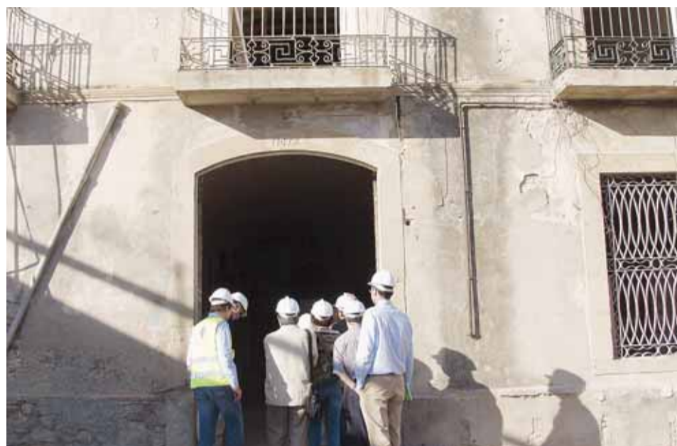
DETALL DE LA FAÇANA DE LA NOVA BIBLIOTECA MUNICIPAL
