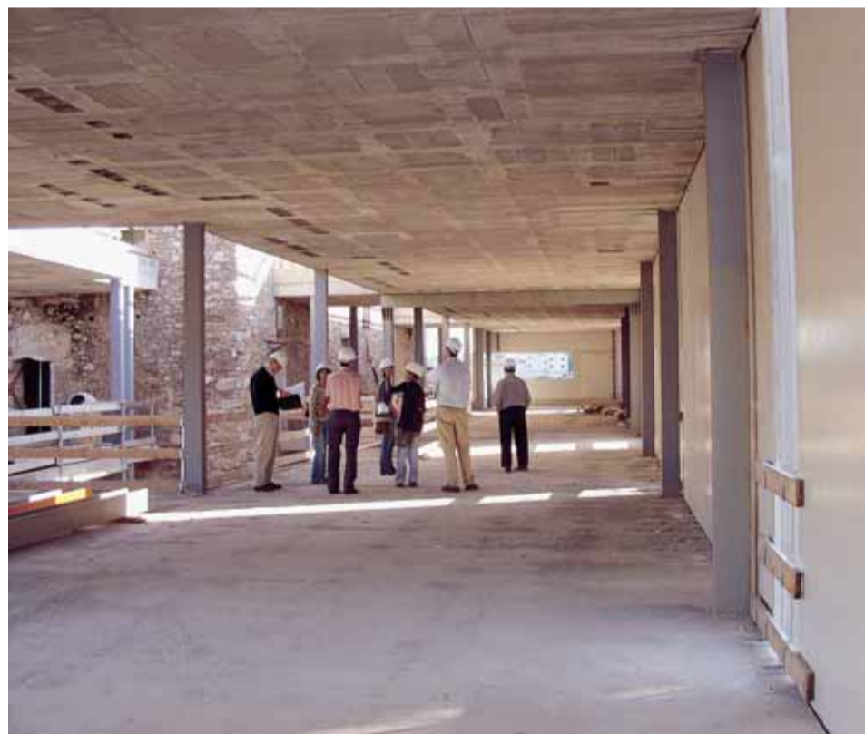
VISITA A LES OBRES
