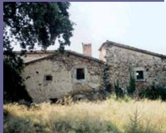
Vista de les construccions més antigues de la masia a la cara nord-oest
