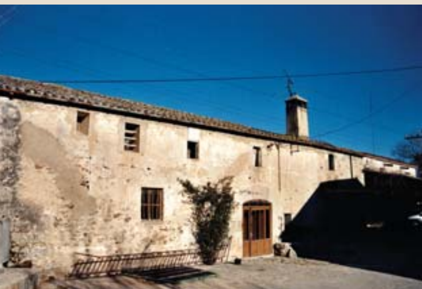
Façana principal del molí d'en Comes. Sota la reixa del terra, la sortida de l'aigua del carcabà.
