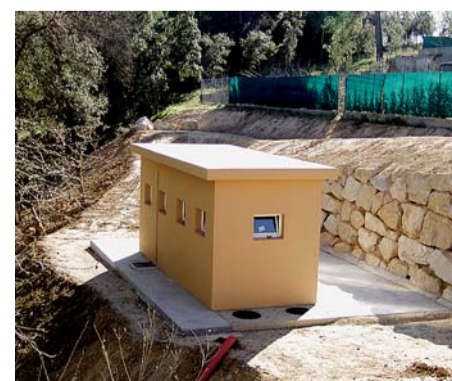
ESTACIÓ DE BOMBEIG
