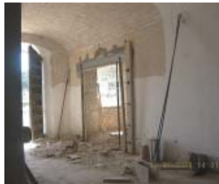
EXECUCIÓ DE DINTELLS I FORATS ALS MURS INTERIORS
