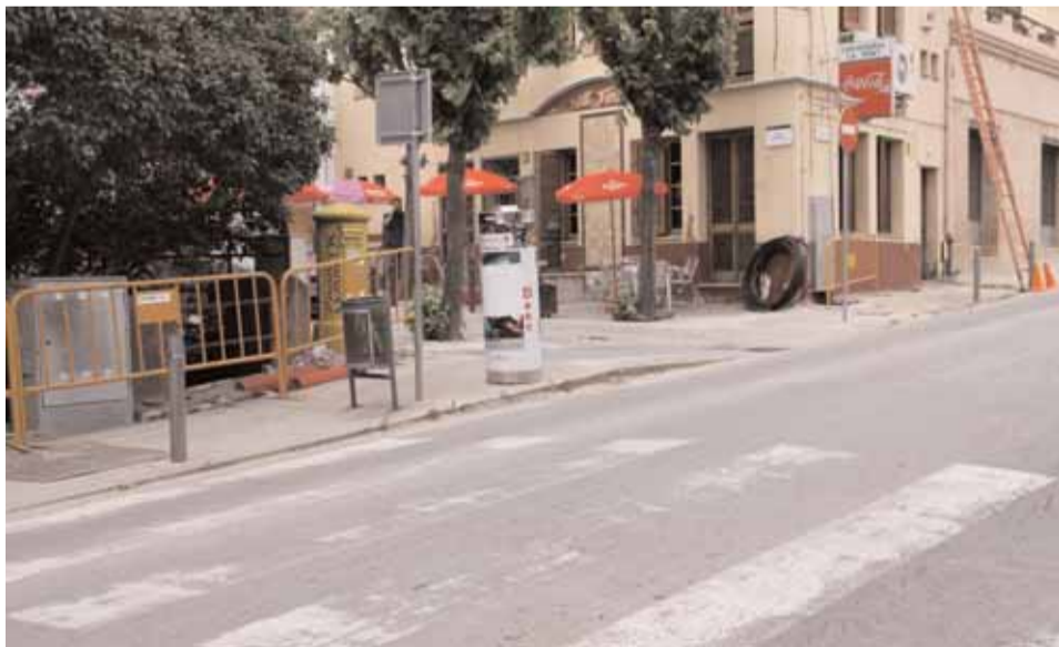
MILLORES DE LA XARXA ELÈCTRICA DEL CENTRE URBÀ
