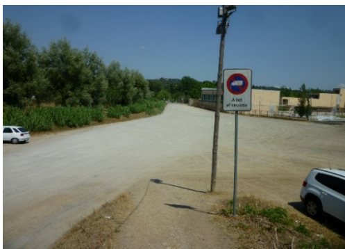
Imatge 19. Vista del tram d'accés amb Països Catalans al fons.
