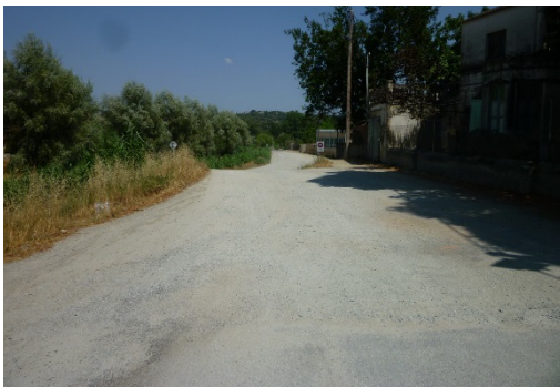
Imatge 23. Vista del vial sense pavimentar des de la sortida del pàrquing inferior.
