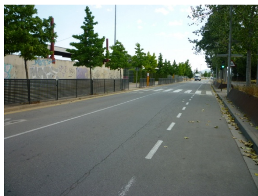
Imatge 18. Tanques de protecció davant de l'IES.
