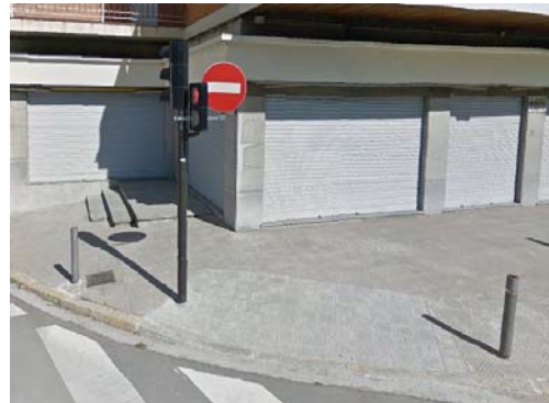
Imatge 11. Rebaix al pas de vianants de carrer del Tenes.
