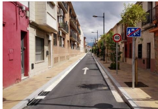
Imatge 41. Exemple d'un altre municipi de l'estrenyiment de calçada amb ampliació de vorera.
