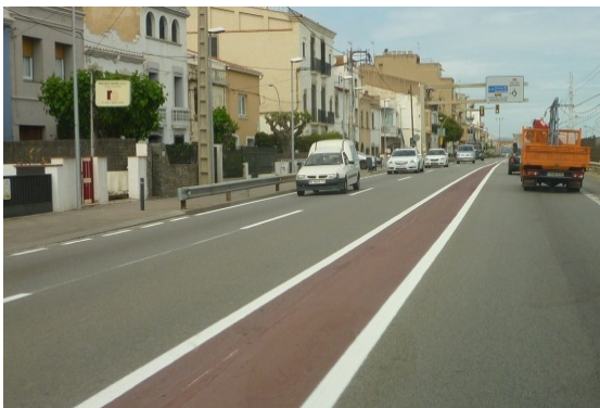
Imatge 40. Exemple d'un altre municipi, en que s'ha establert una mitjana pintada, estrenyent els carrils de circulació.
