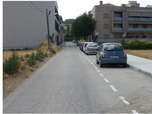
Imatge 32. Vista actual de Pau Claris, amb la vorera recentment executada.
