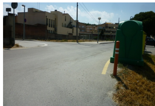
Imatge 28. Contenidors que poden destorbar la visibilitat sortint del pàrquing del nivell inferior.
