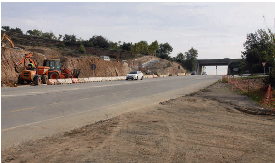
Obres d'enllaç a la C17
