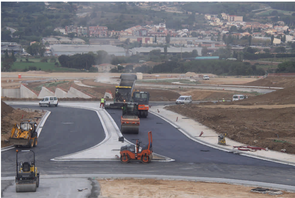
Urbanització del Polígon Industrial de Can Montcau
