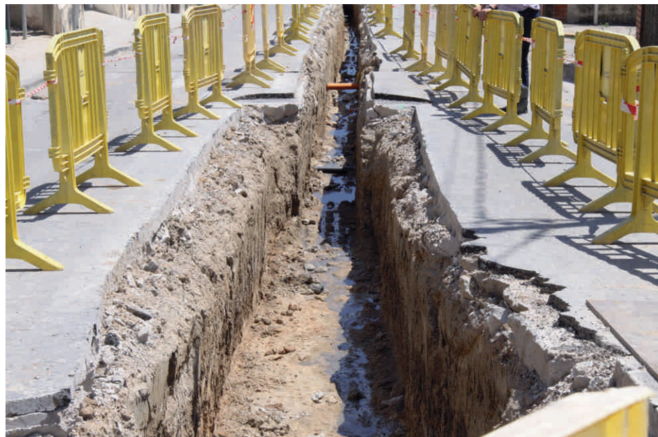
Substitució de la xarxa de clavegueram al carrer de Francesc Macià
