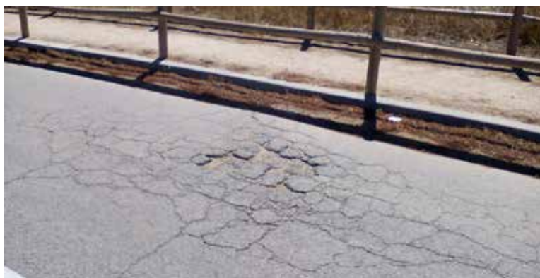
Zona de les obres de Can Rovira Nou.
