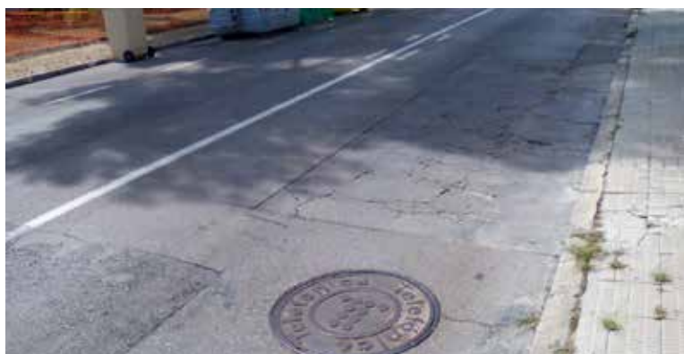
Zona de les obres de Can Salgot.
