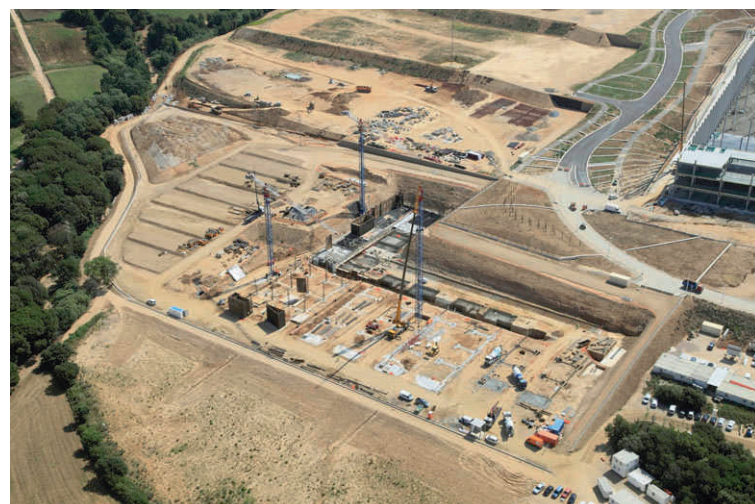
Vista aèria de la construcció (juny de 2014)
