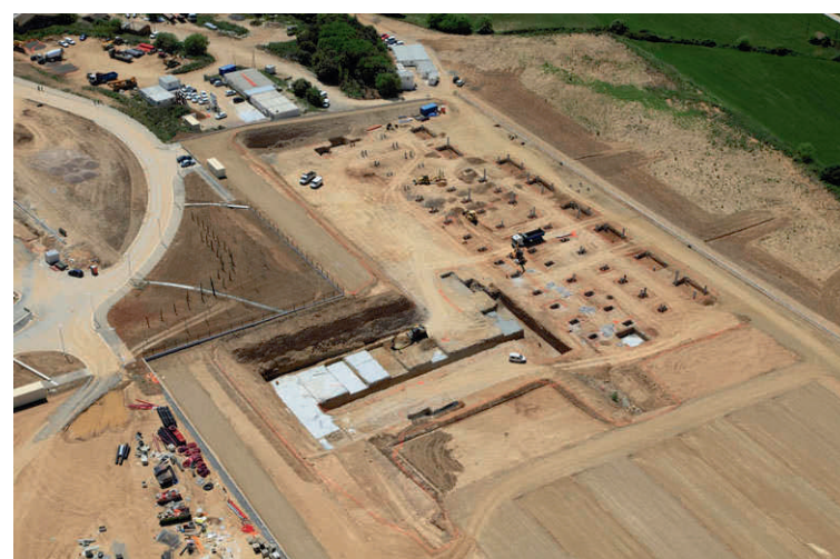
Vista aèria de la construcció (maig de 2014)
