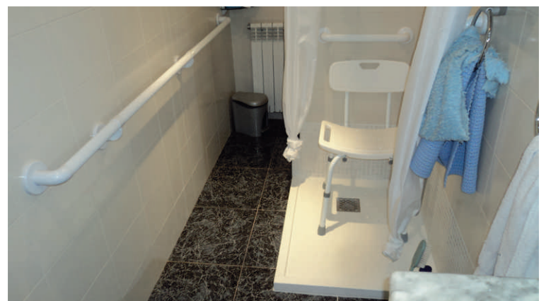
Bany després de la reforma
