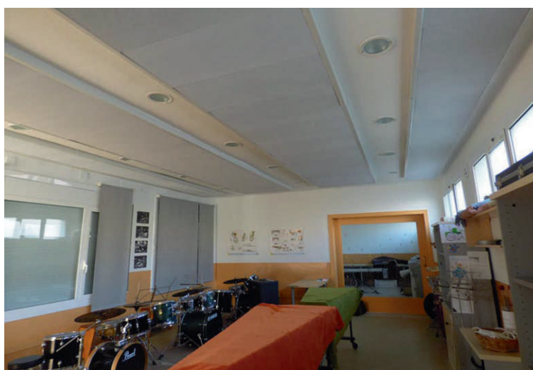
Aula amb les plaques absorbents dels sons
