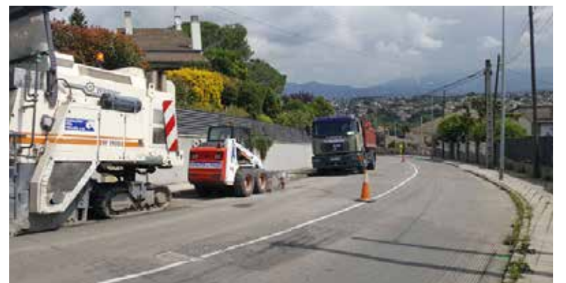
Obres d'asfaltatge al carrer de Ramon Llull del barri de Can Salgot.
