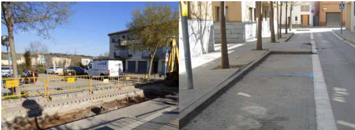
Obres de reparació de la xarxa de clavegueram.
