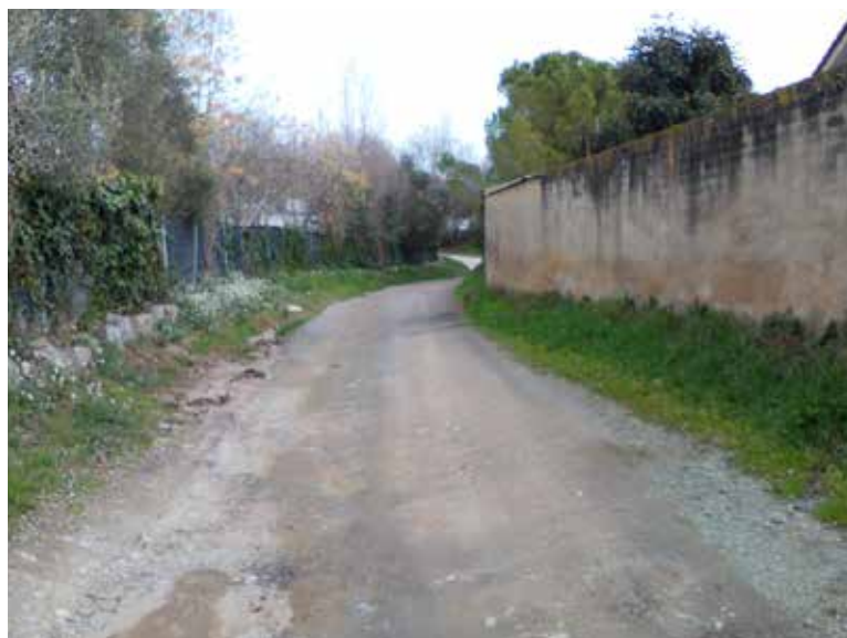
Estat dels carrers abans de l'actuació.
