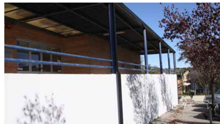
Canalització del porxo d'accés a l'escola Lliçà.
