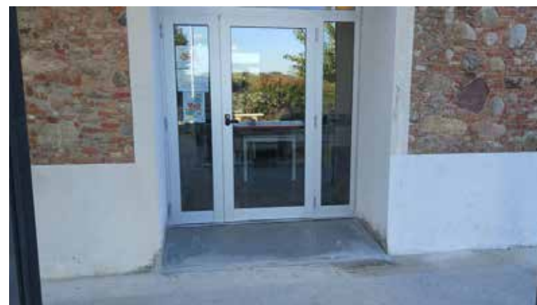
Rampa a la porta lateral de l'Espai Jove El Galliner.
