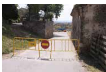
Obres de pavimentació del nucli antic.
