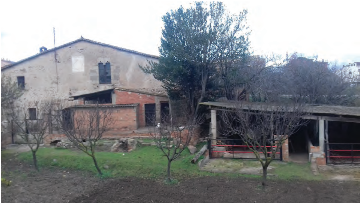
Cobert + magatzem d'obra al frontal de l masia i cobert amb parets d'obra
