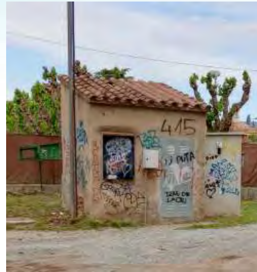
Pou Piscines, caseta del pou.
