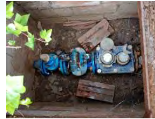
Piscina municipal. Arqueta d'escomesa.
