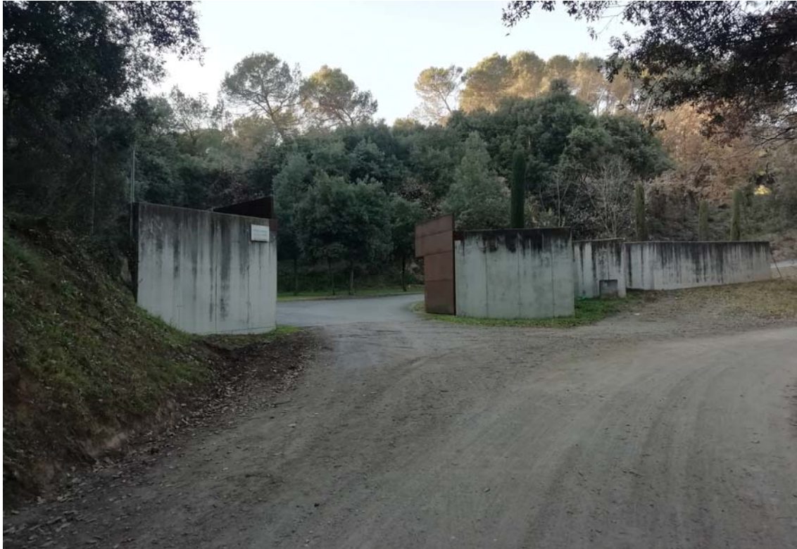
Accés al recinte del cementiri delimitat per una tanca opaca de formigó i una porta opaca de ferro.
