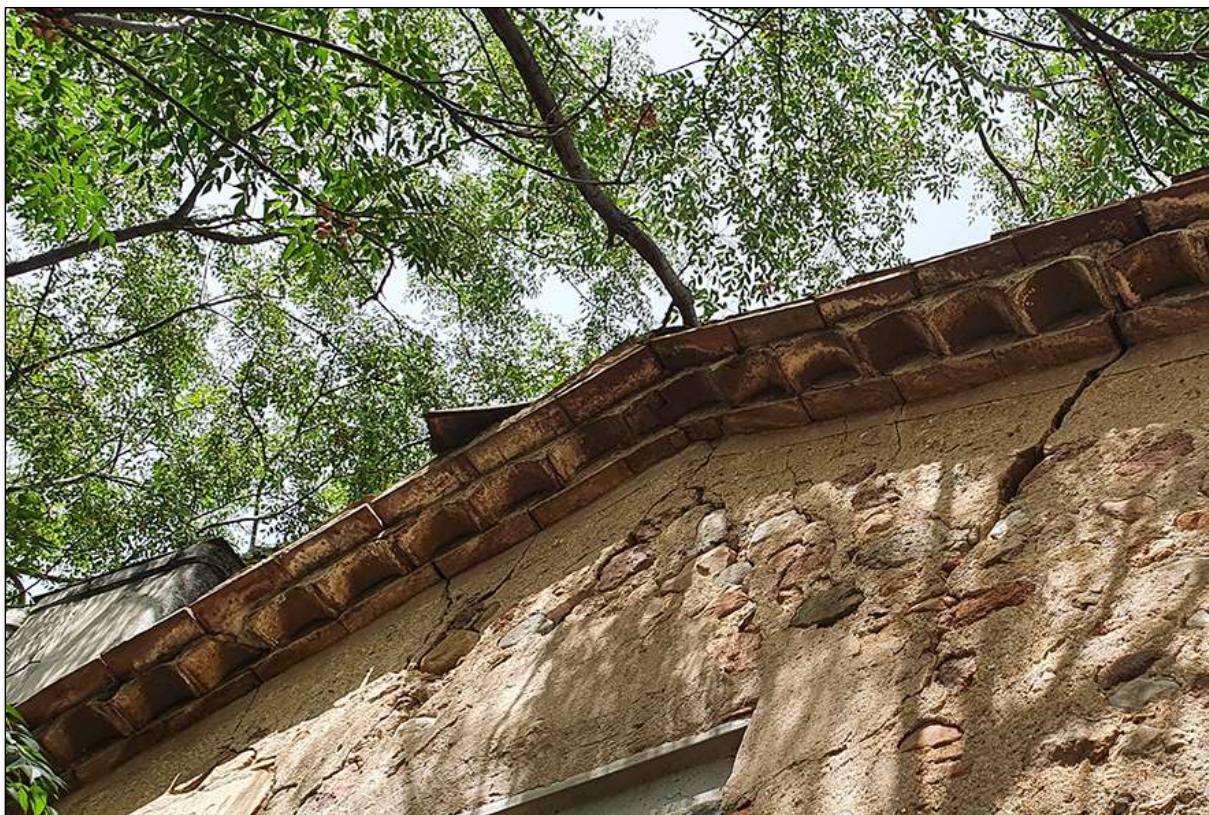
Imatge 186. Ràfec amb triple volada tova, teula capell i tova. Ubicació: Façana principal casa dels masovers.
