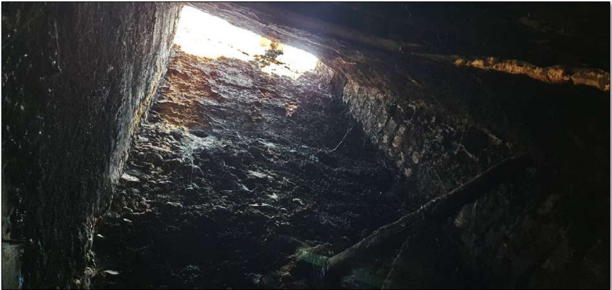
Imatge 247. Tiratge de la llar de foc. No hi ha existència de curull.
