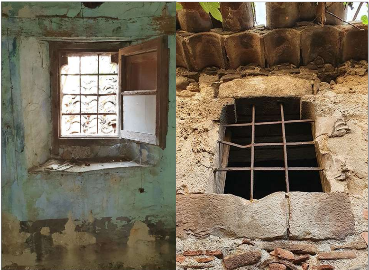
Imatge 95. A l'esquerra vista interior finestra. A la dreta vista exterior de la finestra.
