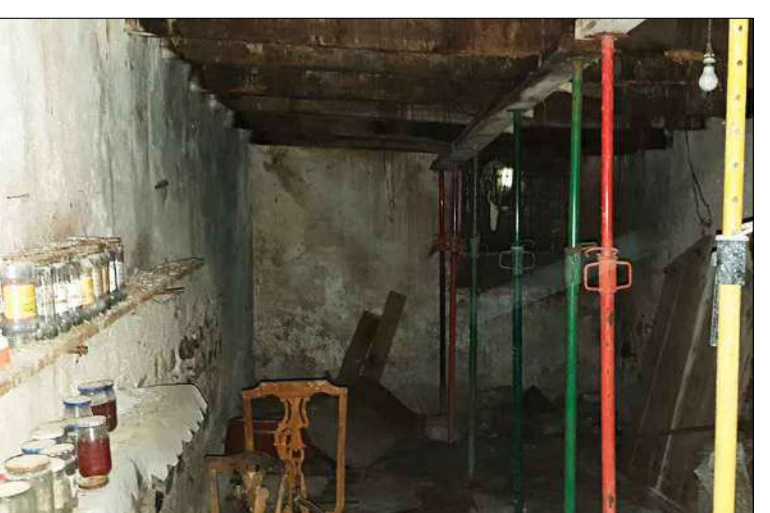
Vista general del rebost. A l'esquerra prestatges amb recipients i mobiliari.
