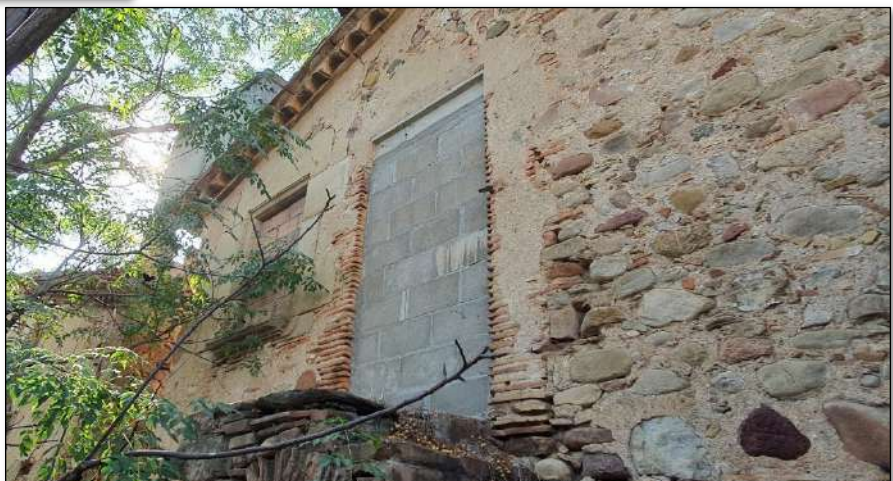
Imatge 219. Vista general façana est de la casa dels masovers.
