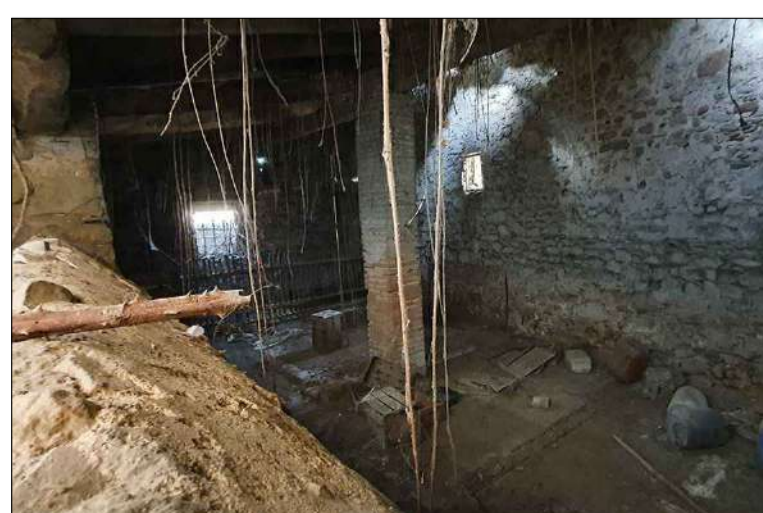
Vista general de la cort de la casa dels masovers. Al centre de la llum del sostre hi ha una jàssera que recolza sobre un pilar de maó per tal de disminuir la llum dels cavalls.
