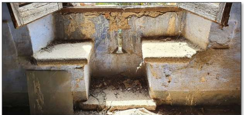
Imatge 52. Detall del festejador del finestral de la sala.
