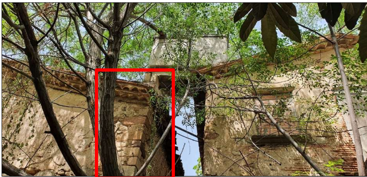
Imatge 112. Cantonades de la masia (edifici esquerra) realitzades amb carreus.
