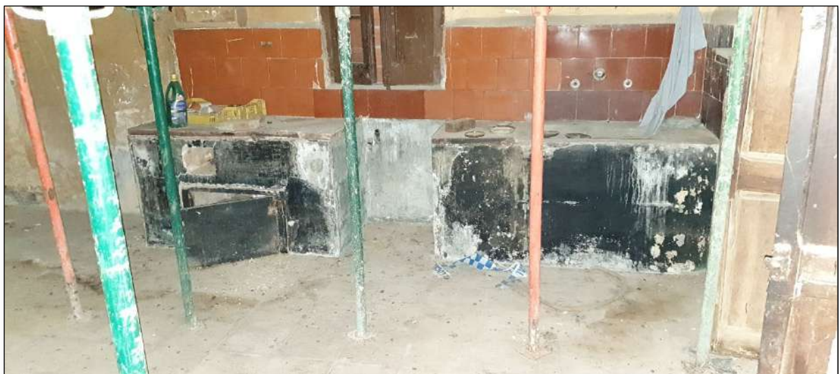
Imatge 223. Revestiment aplicat a base de rajola ceràmica esmaltada sobre la pica i la zona de treball de la cuina.
