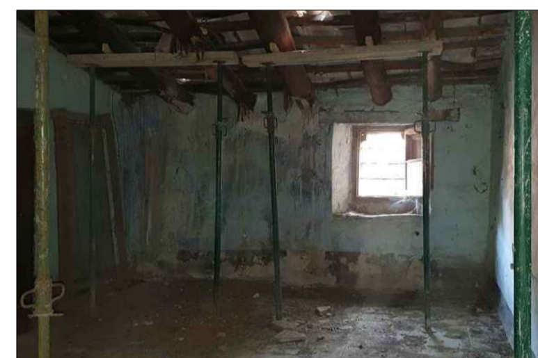
Vista general de l'habitació 2 cap a la finestra.
