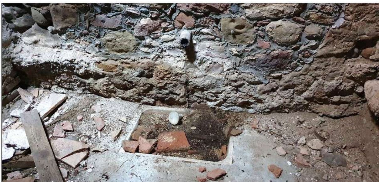
Imatge 32. Pica encastada a terra i broc que surt del mur. Encara hi ha restes de la pasta de verema.
