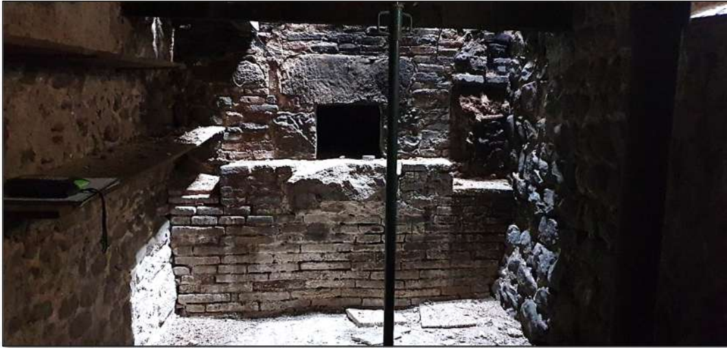
Imatge 23. Forn de 180cms de diàmetre interior de maó.
