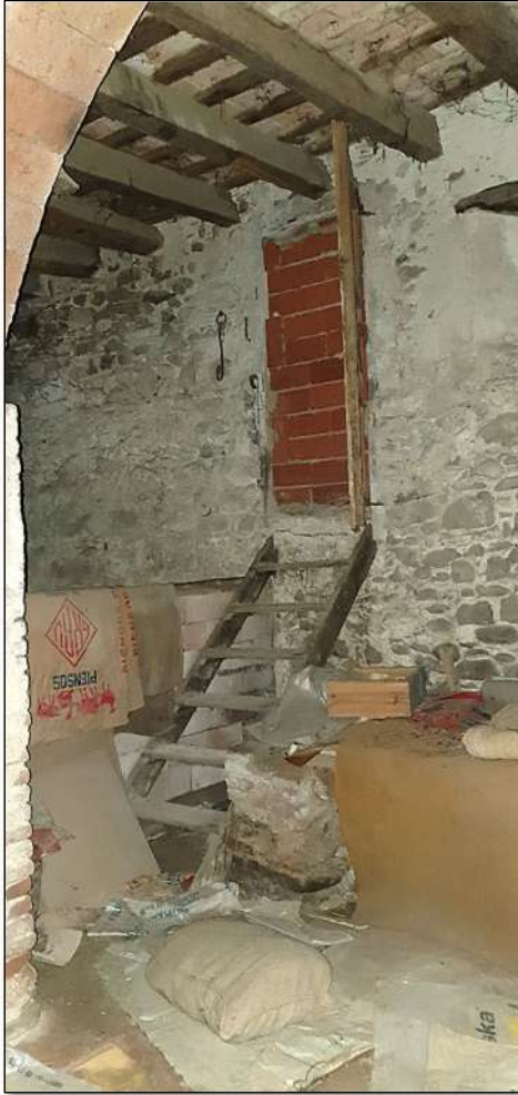
Imatge 33. Escala de fusta de dos muntants i 6 graons per accedir a la part exterior de darrera de la masia.
