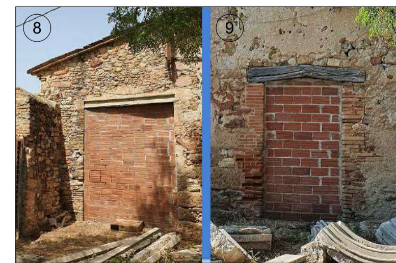
Portes d'accés (tapiades) a diferents espais de la masia. A l'esquerra tenim la portalada d'accés a la zona de garatge i safareig, realitzada amb brancals de pedra i llinda amb biga de formigó.
