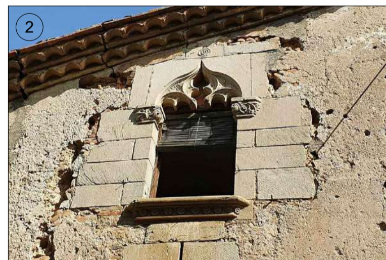
Finestra lateral esquerra de la planta primera, amb arc conopial trilobulat suportat per impostes amb relleus facials i vegetals que recolzen sobre brancals de pedra amb secció quadrada sense cap tipus de decoració.
