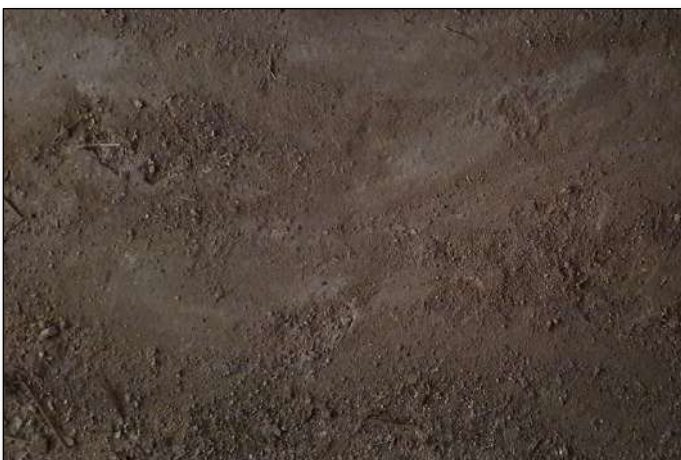
Imatge 189. Paviment de morter barrejat amb calç ubicat en les corts. (zona dipòsits)
