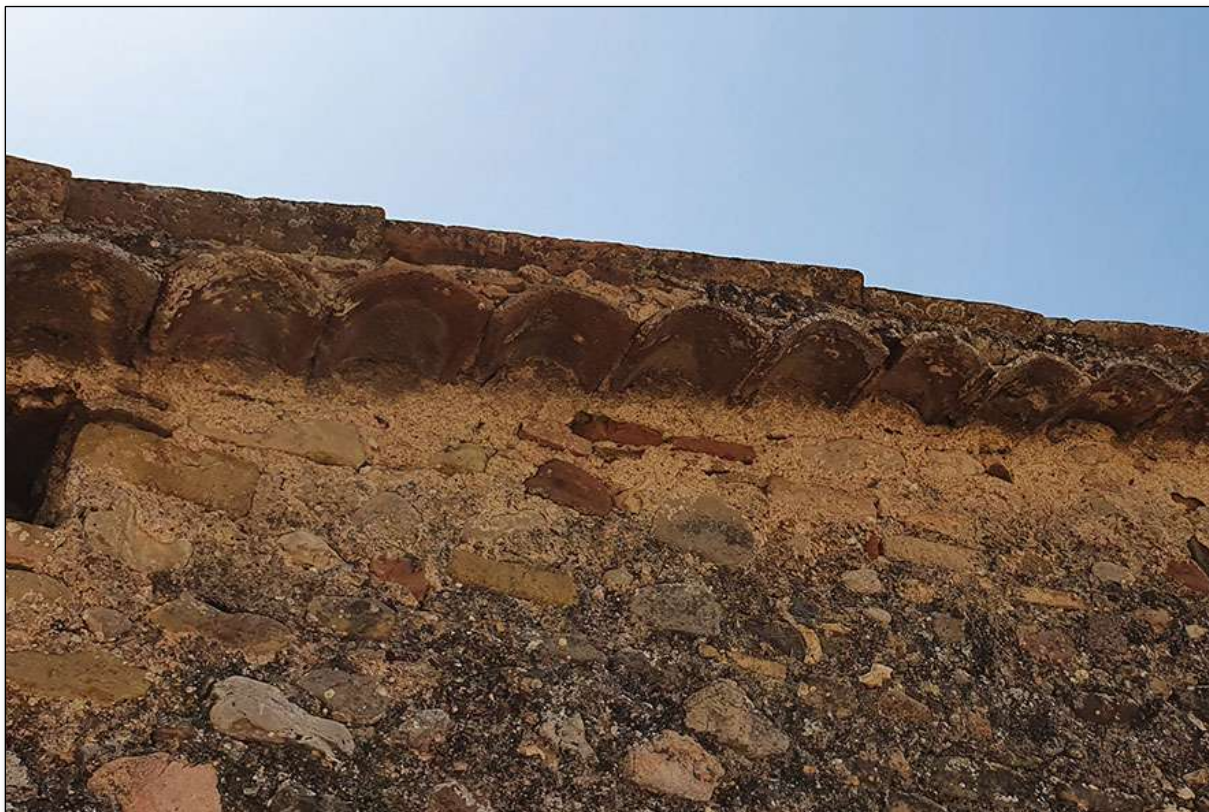
Imatge 185. Ràfec d'una volada simple amb una teula capell creuada. Ubicació: Façana nord de la masia.
