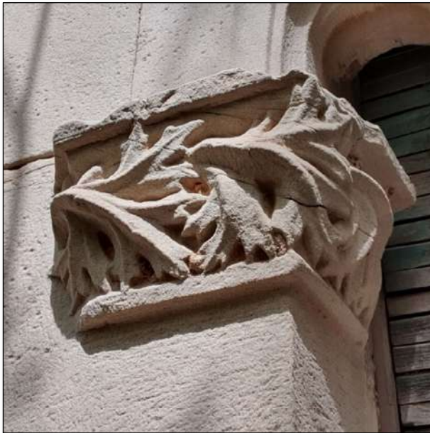
Imatge 64 Detall de les impostes amb les tres franges longitudinals i elements vegetals. La de la dreta està més malmesa.
