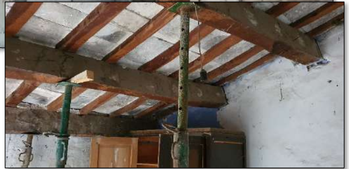
Imatge 160. Vista general i detall (imatge invertida) del sostre inclinat format per bigues (corretges) i llates de fusta de secció rectangular amb tauler ceràmic de tova de 30x30cms i rajol de 15x30cms, ambdues de terra cuita, col·locades a junt seguit i encalades de color blanc. Ubicació: Habitació 7.
