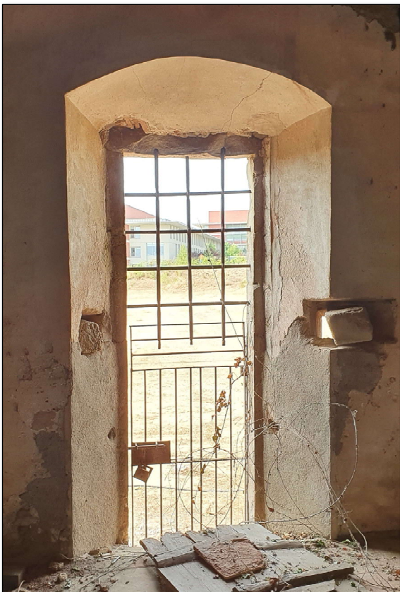
Imatge 106. Porta d'accés cap a l'exterior, a la façana nord. Al costat de cada brançal els passa murs.
