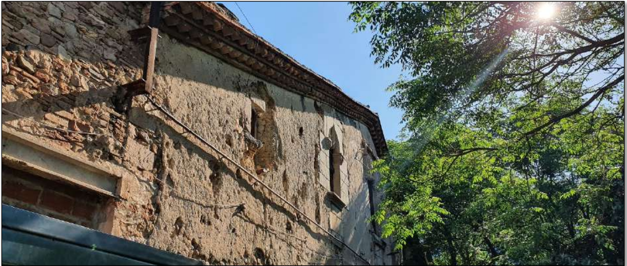
Imatge 217. Vista de l'estat del revestiment aplicat a la façana principal.
