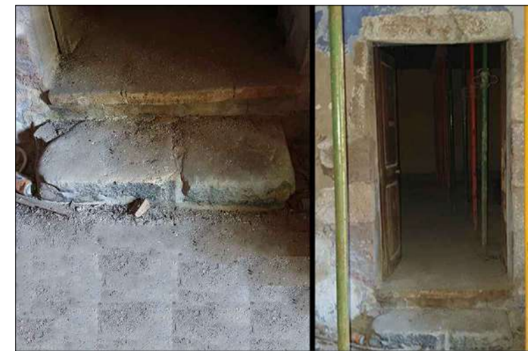
Porta d'entrada a la cuina amb llinda plana de pedra. A l'esquerra detall del graonat d'accés a la cuina,
