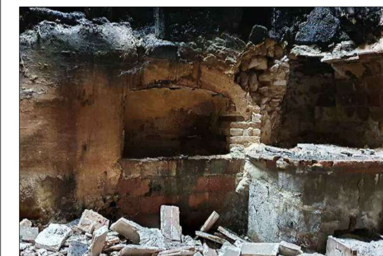
Zona de llar de foc. A la part superior es pot veure la base del ternal giratori per penjar l'olla. La campana, mig enderrocada, és de grans dimensions. A la dreta, el cendrer, per recollir les cendres del foc per fer-lo servir com a detergent per la roba.
