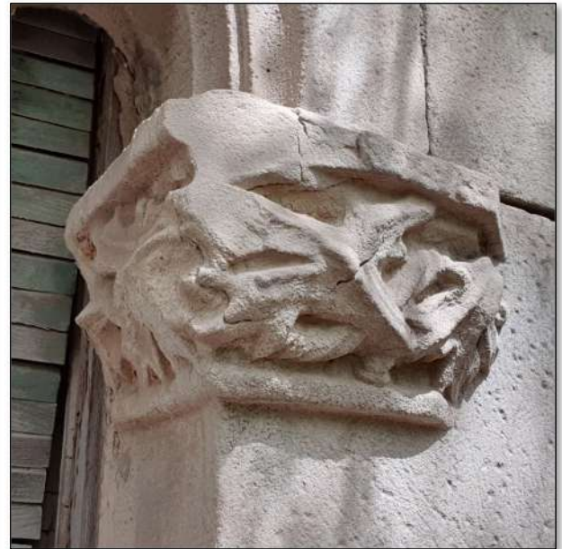
Imatge 64 Detall de les impostes amb les tres franges longitudinals i elements vegetals. La de la dreta està més malmesa.
