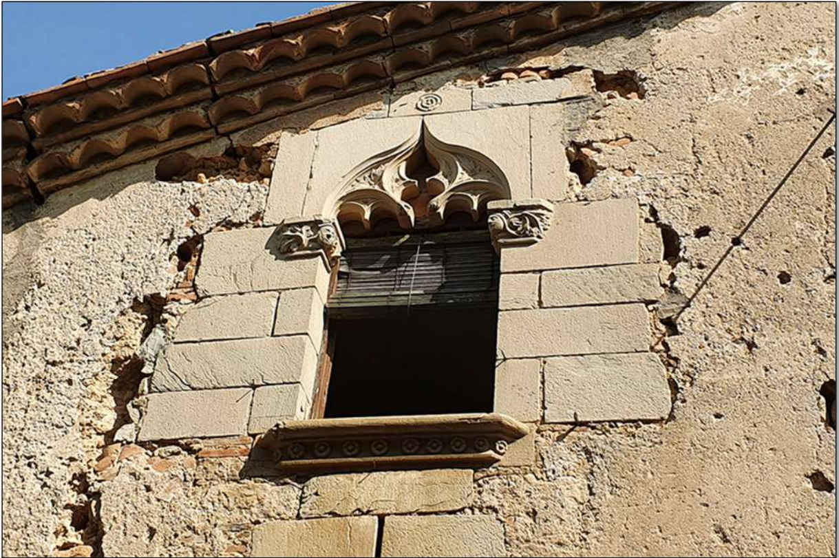
Imatge 72. Finestra de l'habitació 3 vista des de la façana sud.
