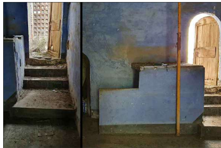
A l'esquerra, l'escala d'accés cap al magatzem del graner. A la dreta, el badalot que protegeix l'escala d'accés a la planta primera.
