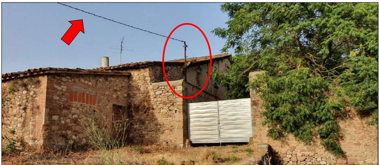
Imatge 227. Escamesa elèctrica aèria fins el permòdol. Es pot veure també una antena de TV-FM
