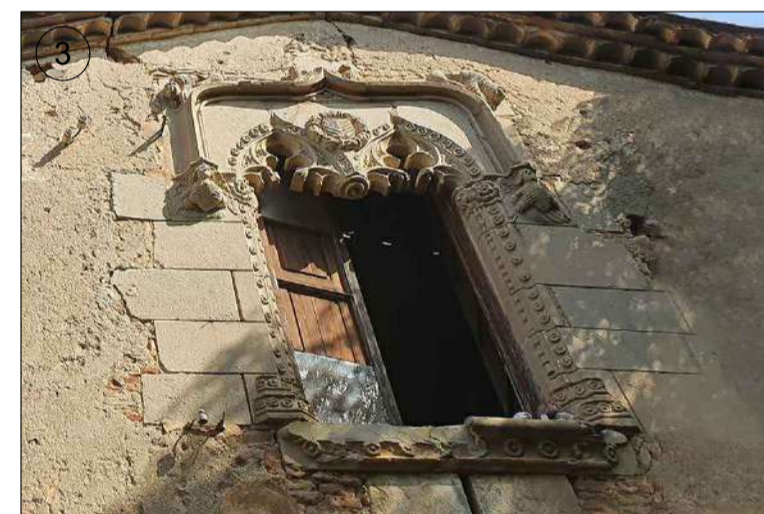
Finestra central de la planta primera, amb arc conopial polilobulat sobre impostes decorades amb dos rostres amb aparença d'àngel amb ales i dues flors.
