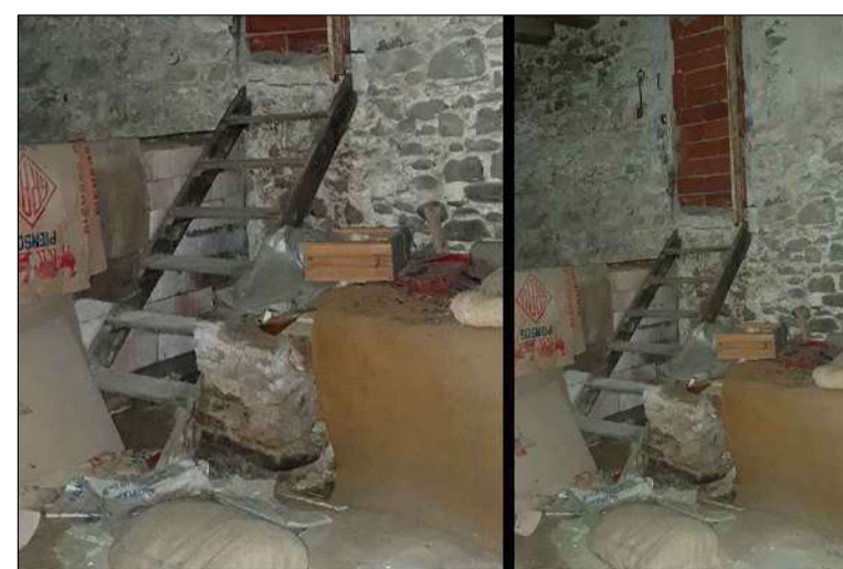
Escala de dos muntants amb graons de fusta per sortir a l'exterior per la façana nord.
