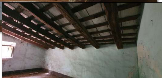
Imatge 158. Vista general i detall del sostre inclinat format per bigues (cavalls) i llates de fusta de secció rectangular amb tauler ceràmic de tova de 30x30cms i rajol de 15x30cms, ambdues de terra cuita, col·locades a junt seguit i encalades de color blanc. Ubicació: Habitació 4.
