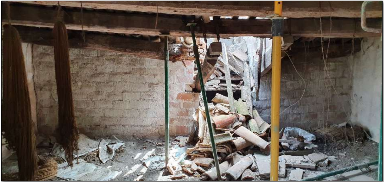
Imatge 107. Vista general escales d'accés a planta parcial superior.
