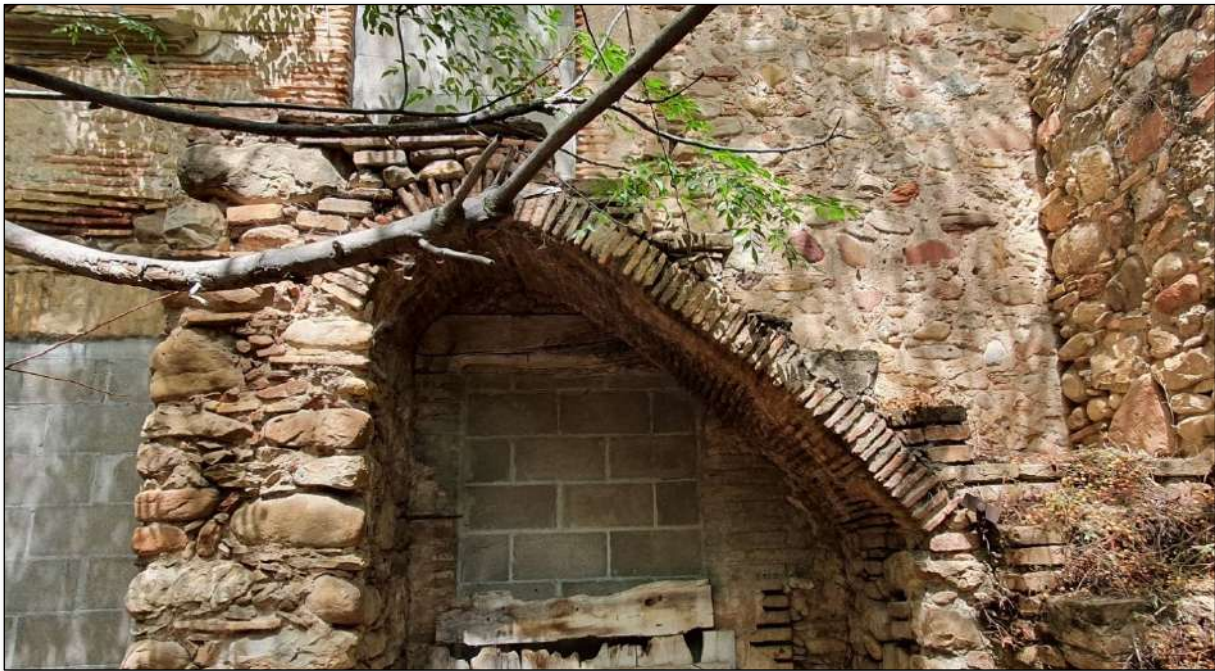
Imatge 116. Realització d'arcs d'escala.
