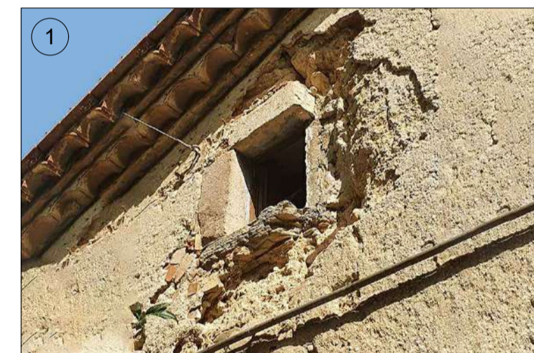
Finestra lateral esquerra composta per llinda plana, brancals i ampit amb pedra calcària de secció quadrada sense cap tipus de decoració.
