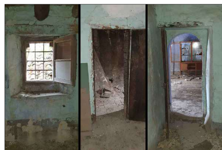
Finestra amb porticó interior i reixa de ferro forjat. En el centre la porta d'accés cap a la cambra calenta. A la dreta, la porta d'accés cap a l'habitació des de la sala principal.
