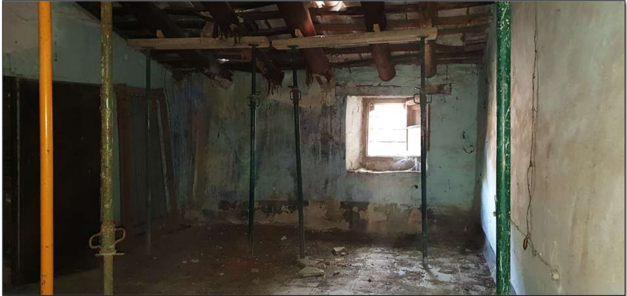
Imatge 94. Vista de l'habitació cap a la façana est. A l'esquerra hi ha la porta d'accés a la cambra calenta.
