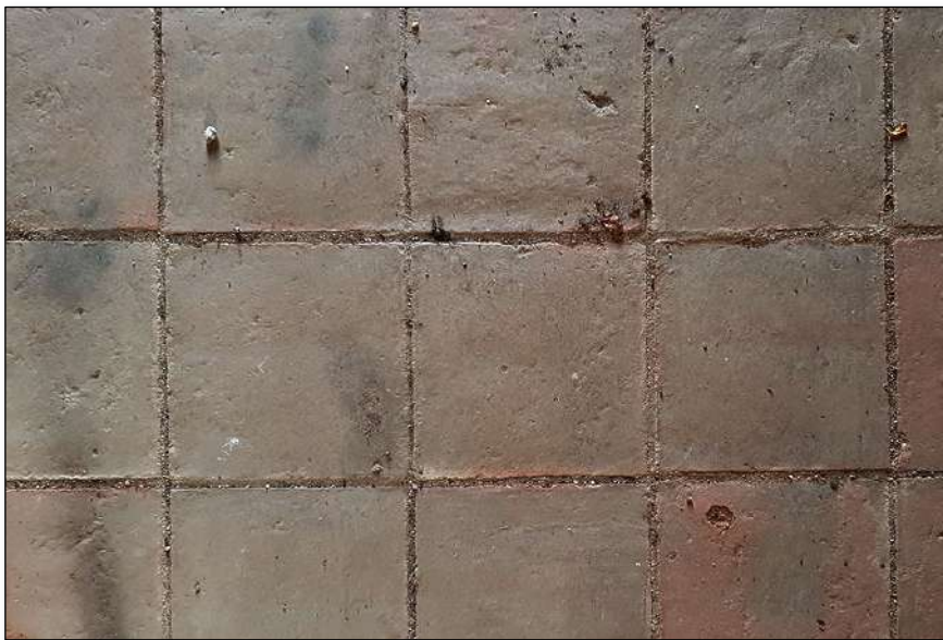
Imatge 214. Paviment del graner.
