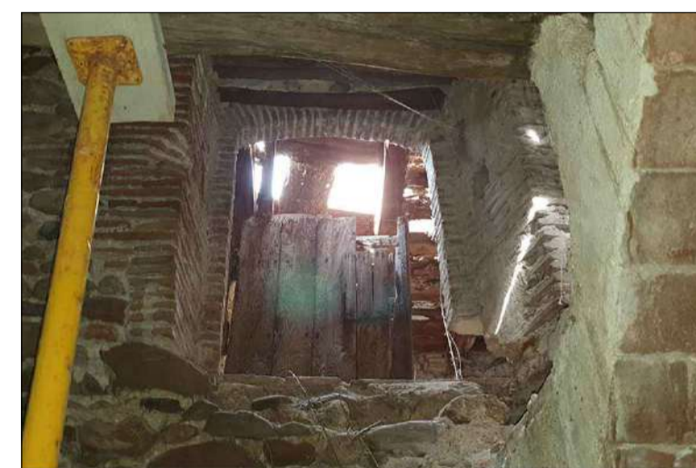
Accés o pas cap a la casa dels masovers que està tapiat i parcialment enderrocat.
