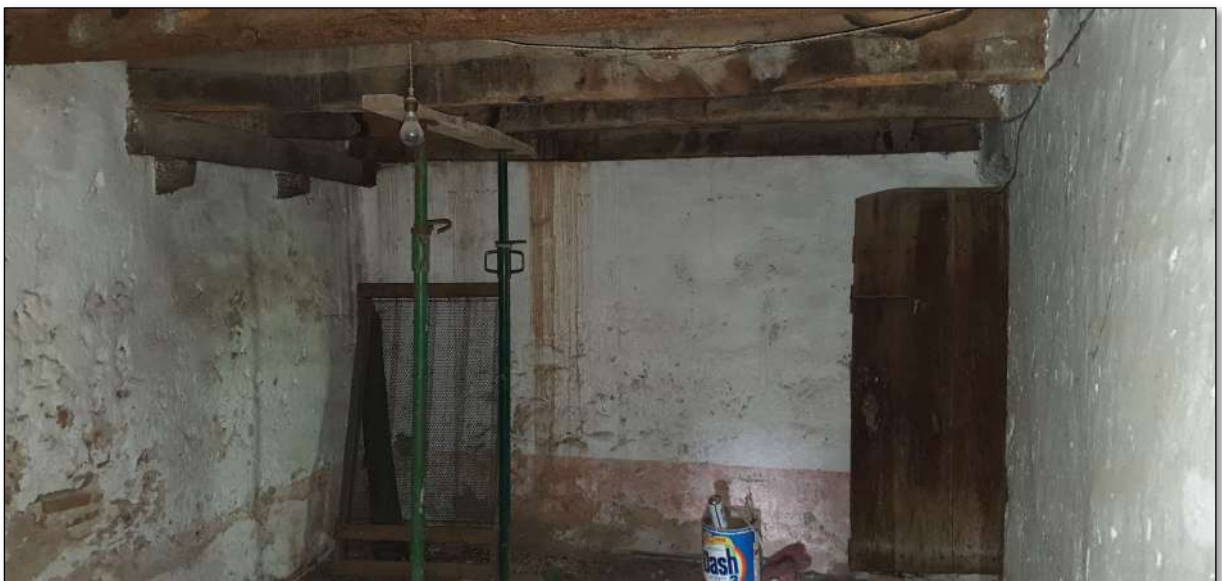
Imatge 89. Vista de l'habitació on es pot veure el sostre de fusta pla,
