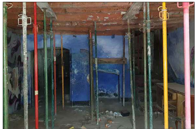
Vista general de la sala principal. A l'esquerra, l'accés cap el celler. A la dreta, l'escala que connecta la planta baixa amb la planta primera i en el seu replà s'hi troba l'accés cap el rebost.
