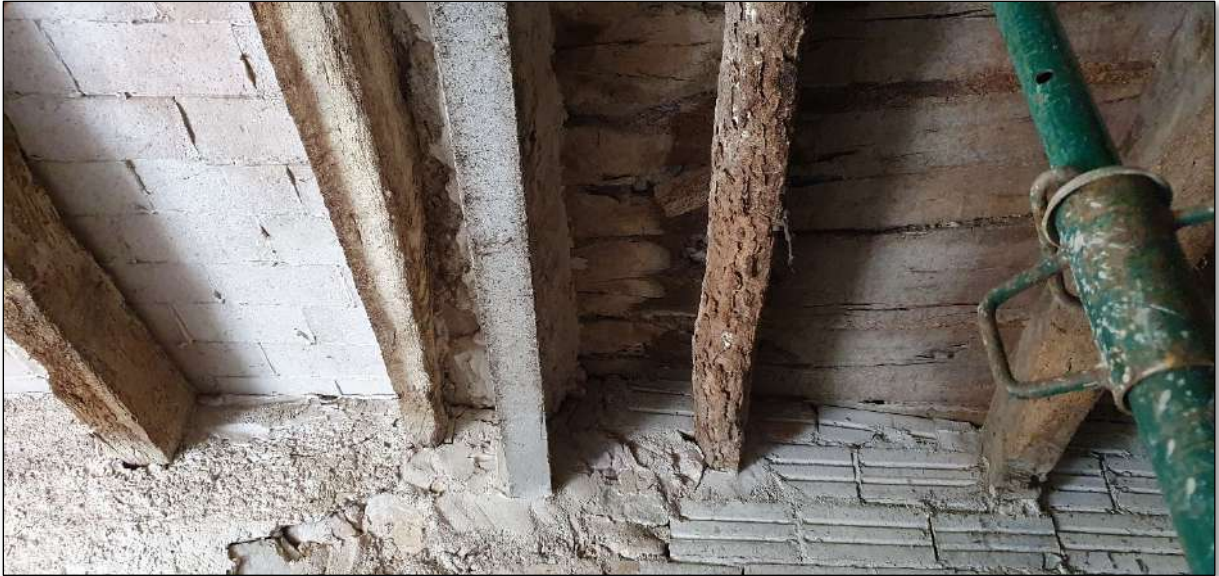
Imatge 132. Forjat horitzontal de bigues de fusta amb tauler ceràmic a l'esquerra i empostissat a la dreta . (Cort)
