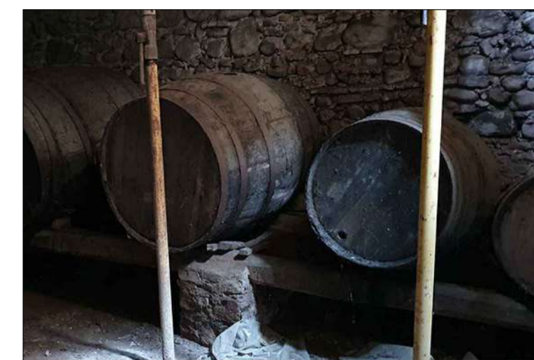
Botes existents de diverses mides. Es recolzen sobre unes bigues de fusta fixades sobre unes pilastres d'obra.
