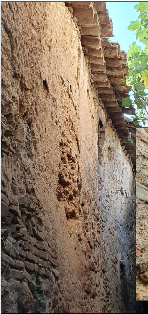
Imatge 124. A l'esquerra vista general del mur de tàpia ubicat en el pas entre la casa dels masovers i la masia. A la dreta detall del deteriorament del mur.
