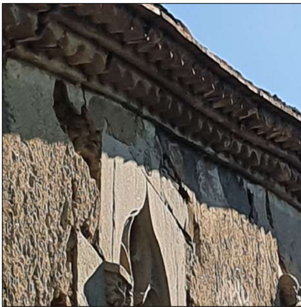
Imatge 117. Formació de diferents tipus de cornises en ràfecs.
