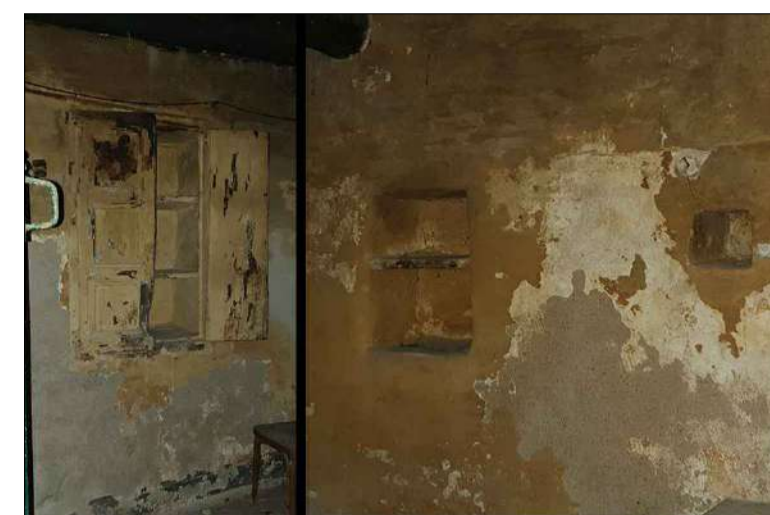
Diferents obertures encastades en els murs, que servien d'emmagatzematge de petits utensilis.
