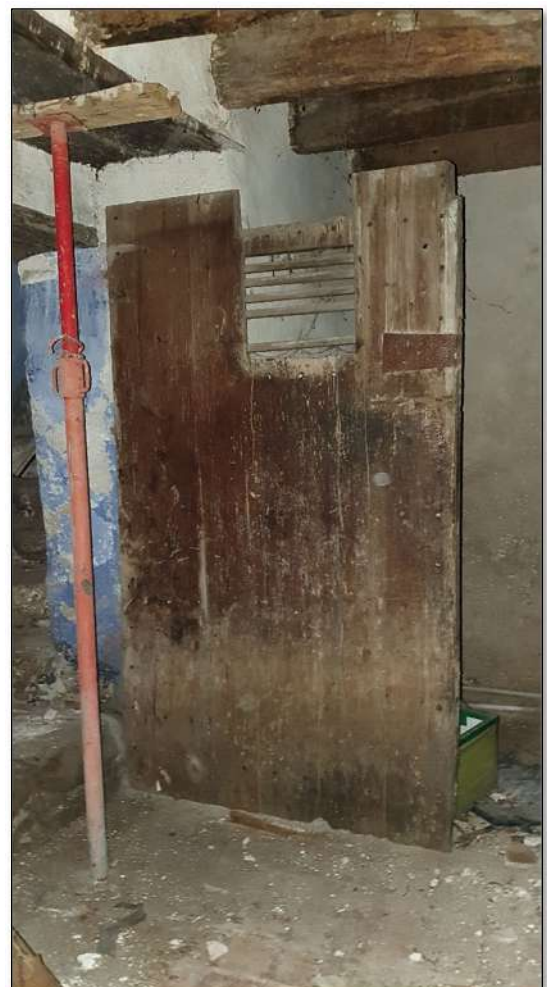
Imatge 43. Porta del rebost amb ventilació a la part superior.
