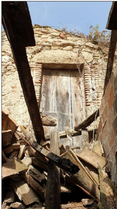
Imatge 108. Porta d'accés a la doble planta del celler. L'accés està vetat per la runa acumulada sobre l'escala i el seu mal estat de conservació.
