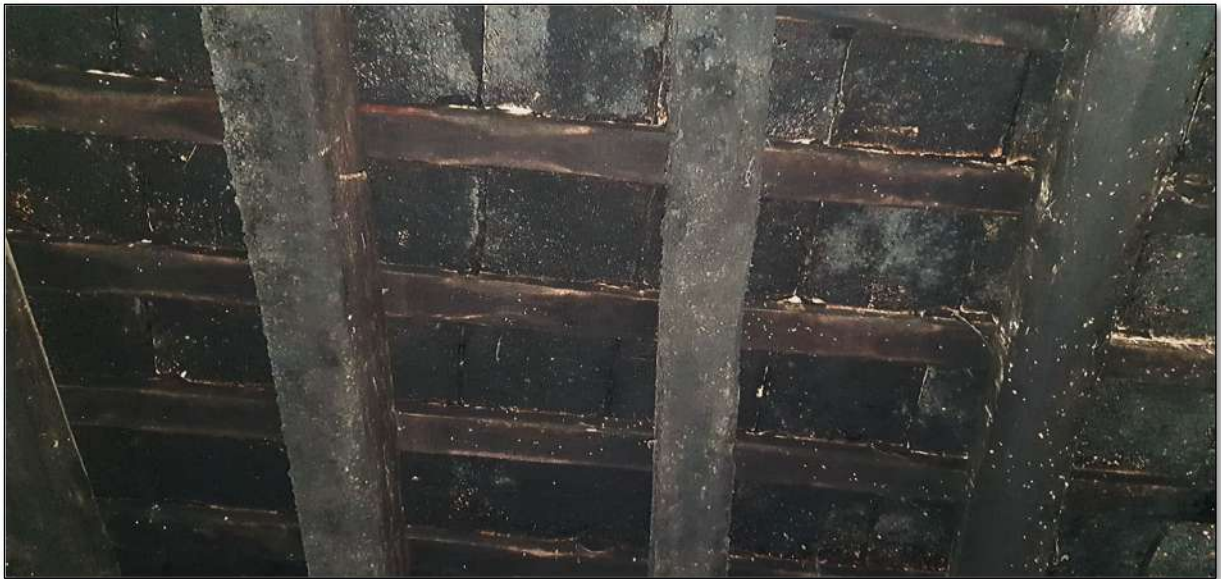
Imatge 140. Forjat de bigues de fusta rectangulars de secció variable i tauler de tova massissa de terra cuita de 30x30cms, a junt continu, col·locat sobre llatges de fusta. Ubicació: Cuina menjador.
