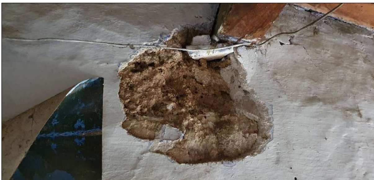
Imatge 120. Mur mitger entre l'habitació 5 de la 7. Es pot veure la composició del mur. El revestiment s'ha després.
