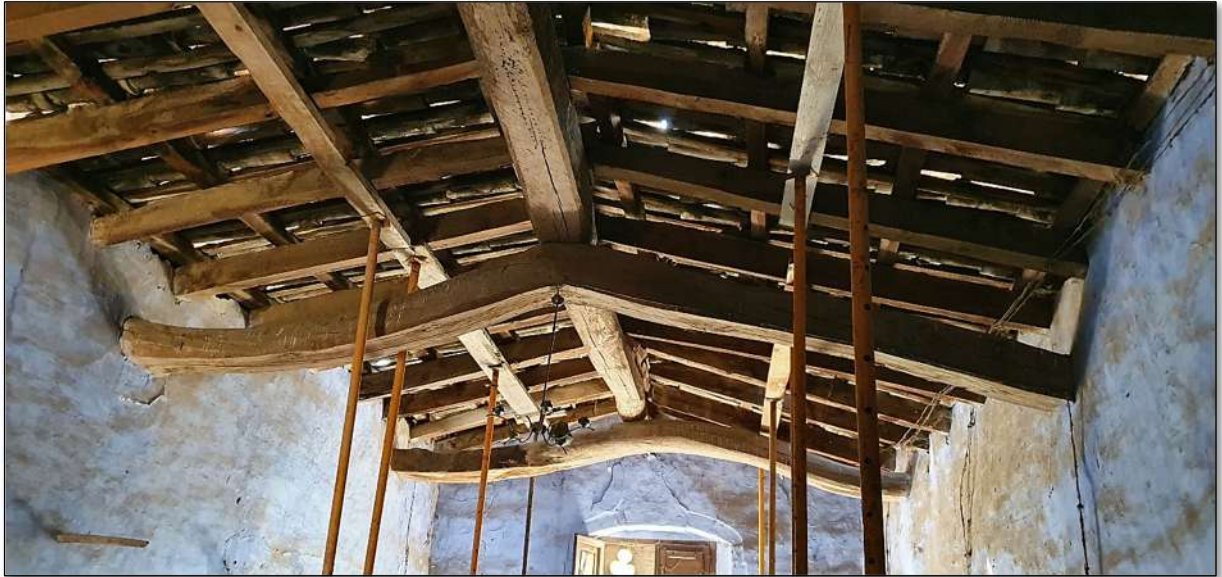
Imatge 50. Coberta inclinada a dues aigües utilitzant la tècnica de llata per canal sobre corretges i cavalls. La jàssera carenada, perpendicular a la façana, està recolzada sobre encavallades encorbades.
