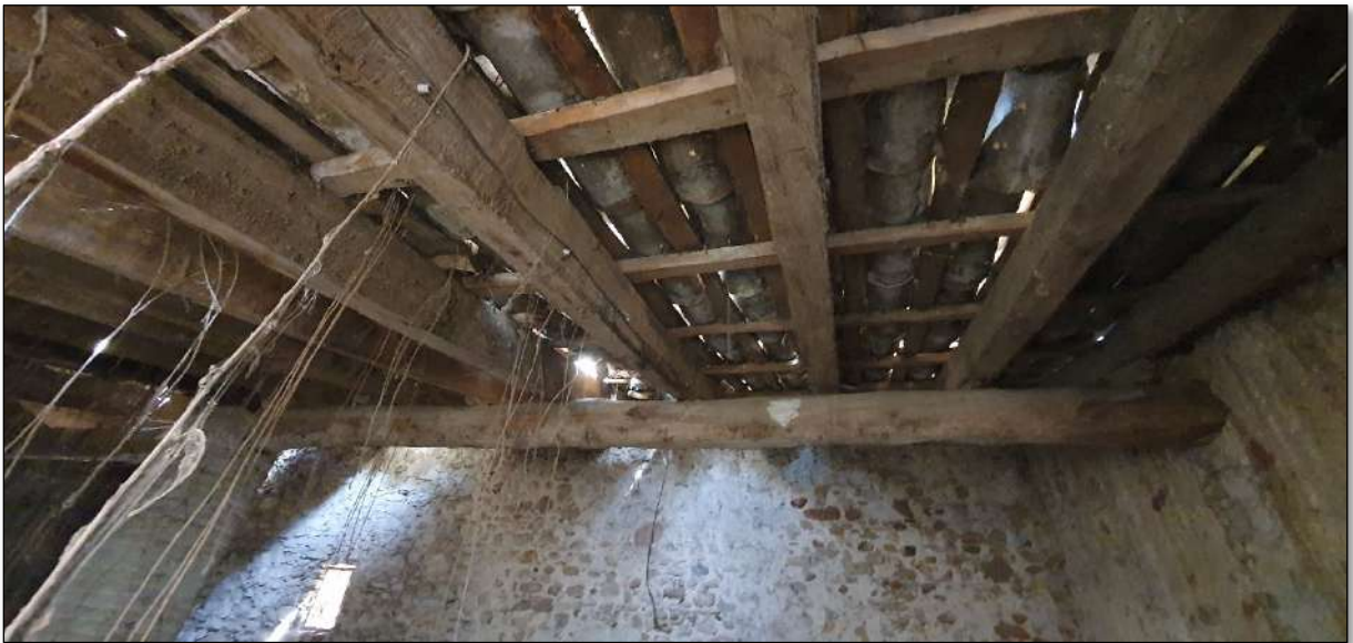
Imatge 149. Tècnica de "llata per canal" sobre llates, clavades a corretges i aquestes a les bigues de fusta (cavalls). Ubicació: Corts de la casa dels masovers.
