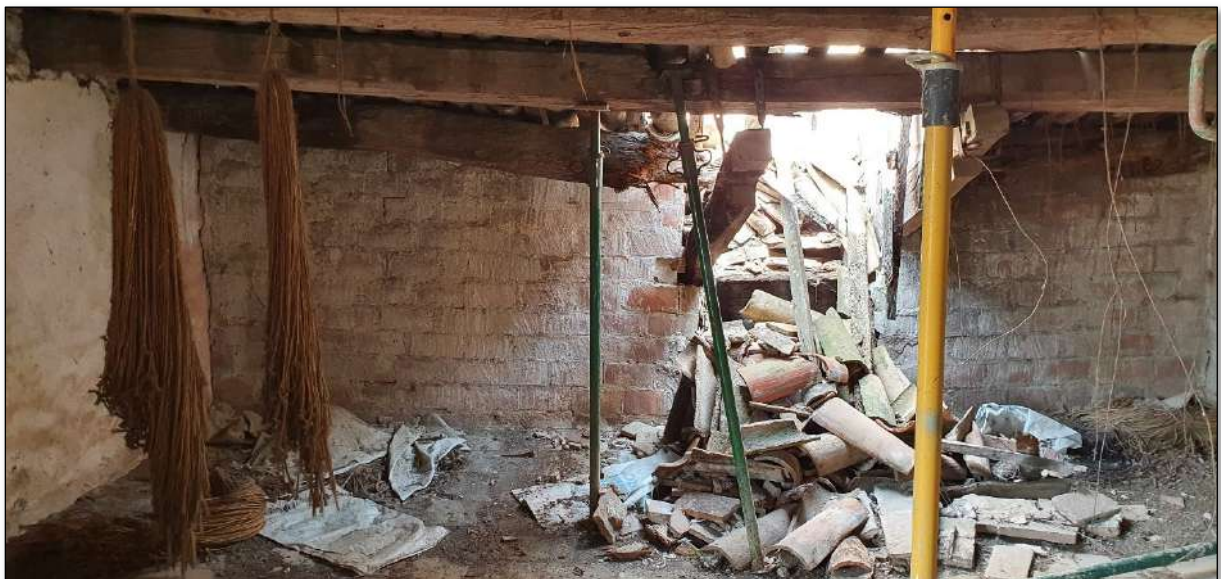
Imatge 125. Envà, de 5cms de gruix, per a separació del graner i el doble espai del celler de la planta baixa. Al centre l'escala d'accés a la planta més alçada.
