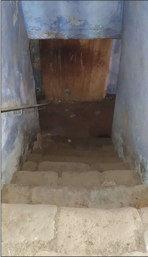
Imatge 174. Segon tram d'escala amb la seva barana de pipes de ferro. Vista des de la planta primera
