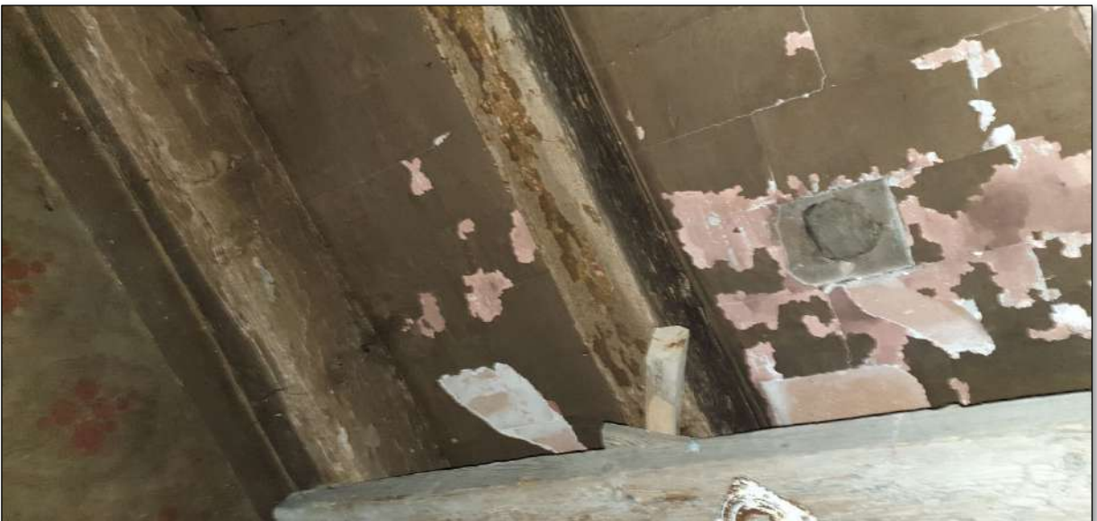
Imatge 137. Forjat horitzontal de bigues de fusta de secció rectangular variable i tauler ceràmic de rajola massissa manual de 15x30cms de terra cuita col·locada a trencajunts i entrebigat enlluït i pintat. Ubicació: Menjador.
