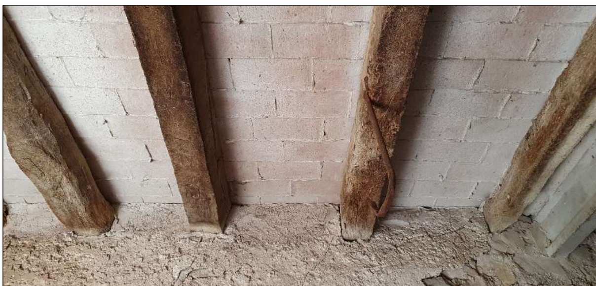
Imatge 139. Forjat horitzontal de bigues de fusta de secció variable rectangular amb tauler ceràmic de rajola massissa manual de 15x30cms de terra cuita col·locada a trencajunts. Ubicació: Cort.
