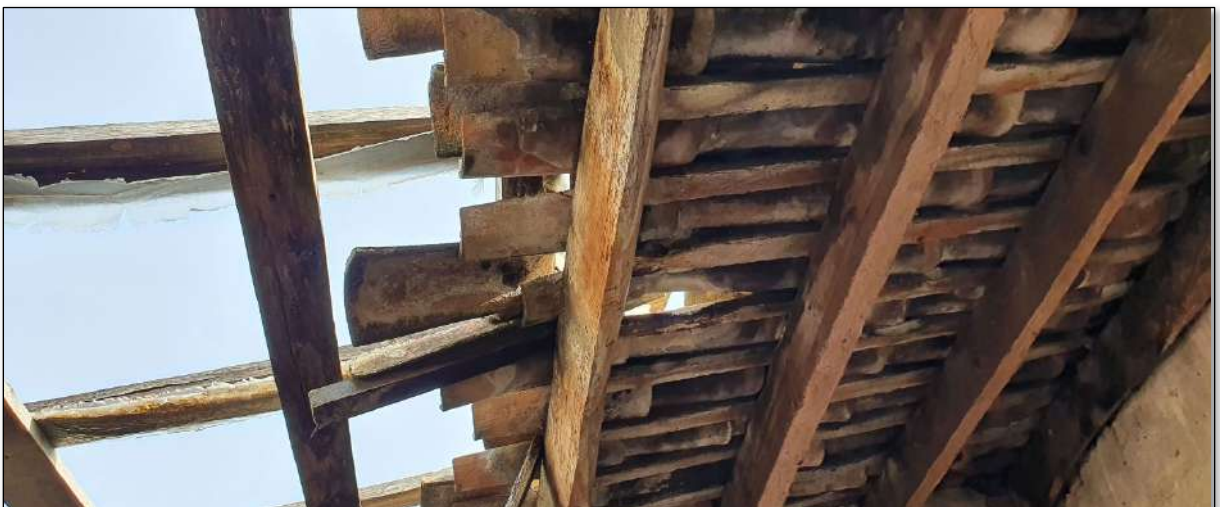
Imatge 150. Tècnica de "llata per canal" sobre bigues de fusta (corretges). Ubicació: Magatzem del graner.
