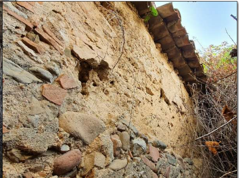
Imatge 124. A l'esquerra vista general del mur de tàpia ubicat en el pas entre la casa dels masovers i la masia. A la dreta detall del deteriorament del mur.
