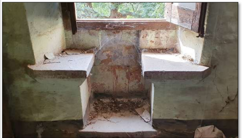
Imatge 71. Detall del festejador, es troba en bastant bon estat de conservació i el mirador també ha estat anul·lat.
