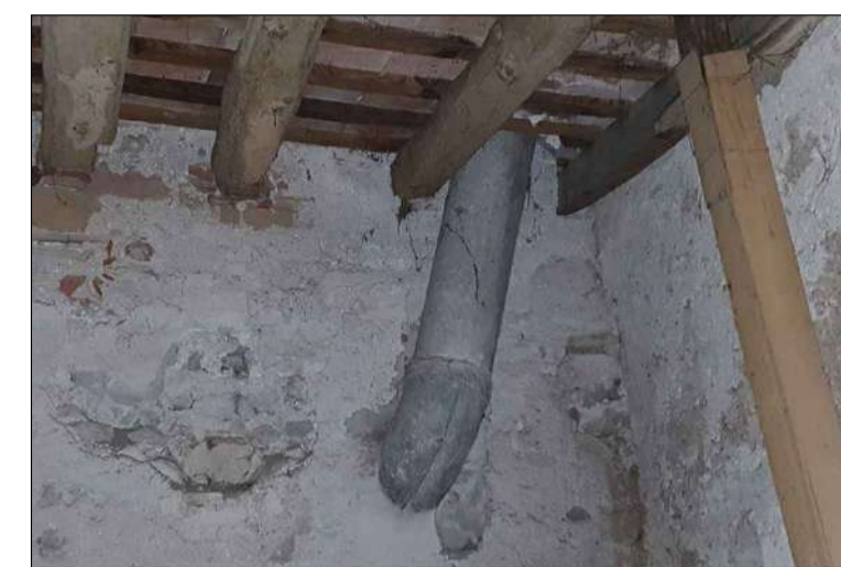
Ventilació realitzada amb tub de fibrociment que va fins a la teulada passant per dos forjats, el sostre del celler i el del graner (coberta).
