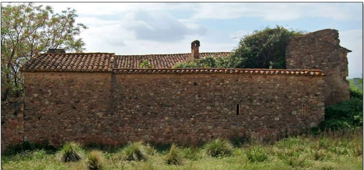
Imatge 248. Vista des de la façana est. El curull de la xemeneia és existent.
