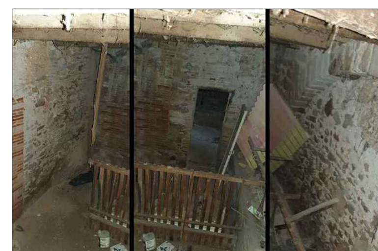
A l'esquerra de l'accés hi ha un mur de maons que oculten les canalitzacions de desguàs que connecten amb el pou mort. En el centre, el pas cap a la cort inaccessible 1 i a la dreta, un arc de pedra tapiat. Adjacent a aquest, s'hi ubica el menjador.
