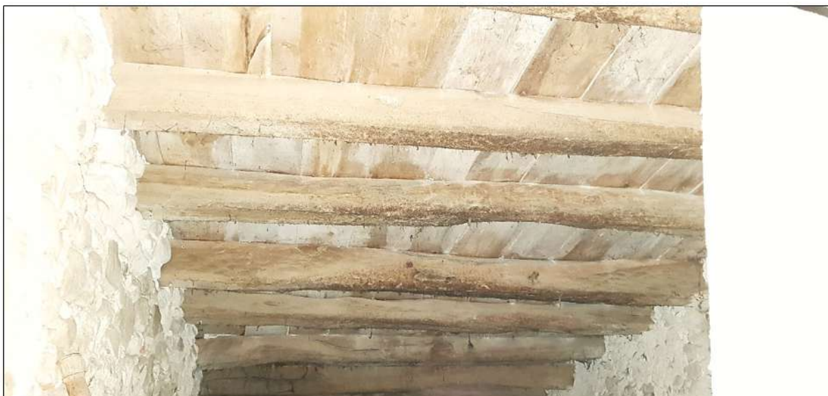
Imatge 134. Forjat horitzontal de bigues de fusta amb tauler de fusta de la cort inaccessible 1.
