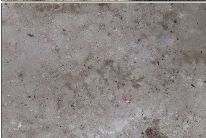
Imatge 191. Paviment de morter barrejat amb calç ubicat en l'obrador.
