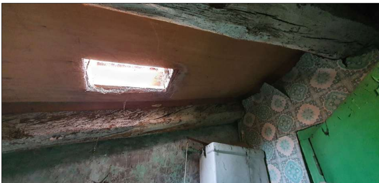
Imatge 82. Lluernari existent en sostre inclinat per a il·luminació del bany.
