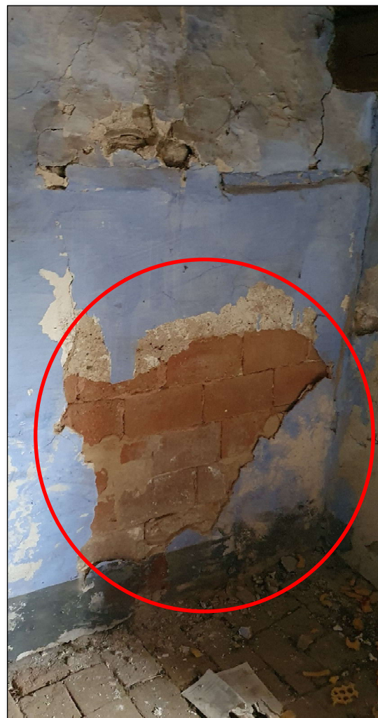
Imatge 245. Envà de maó de cantell en l'habitació 5. Darrera hi ha el inodor del bany.
