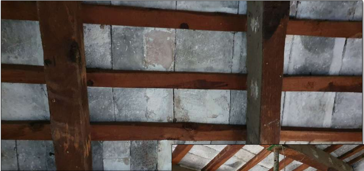
Imatge 160. Vista general i detall (imatge invertida) del sostre inclinat format per bigues (corretges) i llates de fusta de secció rectangular amb tauler ceràmic de tova de 30x30cms i rajol de 15x30cms, ambdues de terra cuita, col·locades a junt seguit i encalades de color blanc. Ubicació: Habitació 7.
