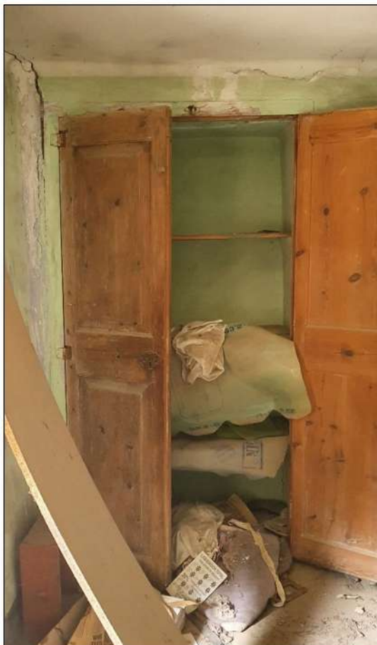
Imatge 67 Armari encastat en mur
