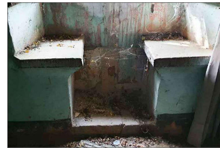
Detall del festejador existent. L'espell ha estat tapiat.
