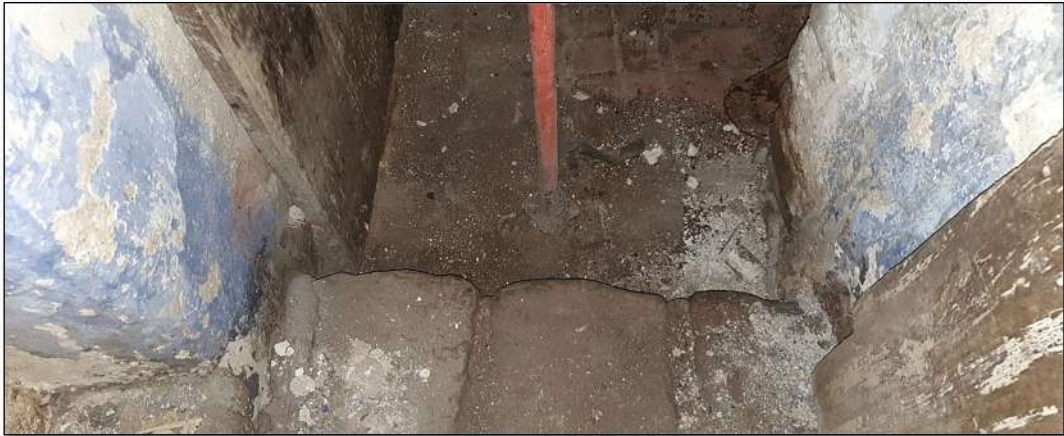
Imatge 44. Graó d'entrada al rebost. És un graó de 25cms d'alçada.
