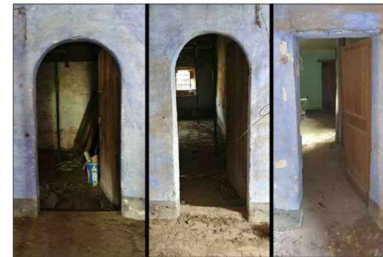
Obertures cap a les diferents estances: a l'esquerra, cap a l'habitació 6 i al mig cap a l'habitació 2, totes dues amb arc capçalat de Sant Antoni; a la dreta la porta d'accés a l'habitació amb llinda plana.
