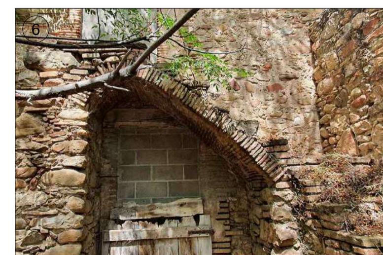
◀ Escala d'accés a la planta primera de la casa dels masovers, formada per murs de pedra i arc rampat de maó massís en sardinell, per a suport d'esglaonat de maó massís.
