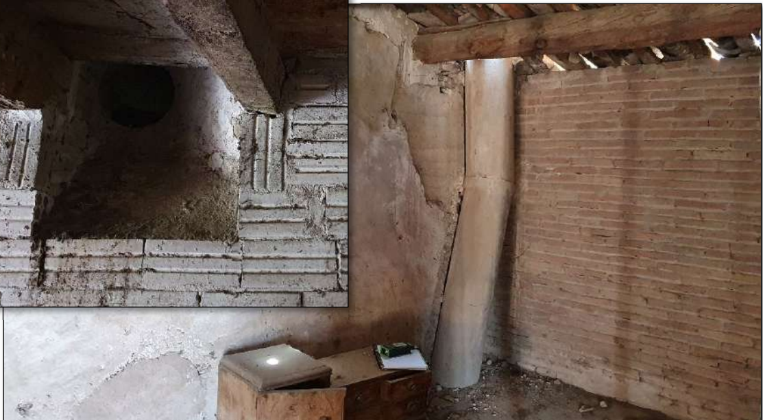
Imatge 250. Tub de formigó per a ventilació. A l'esquerra la boca del tub a la cort. A la dreta el recorregut del tub en el graner de la planta primera.
