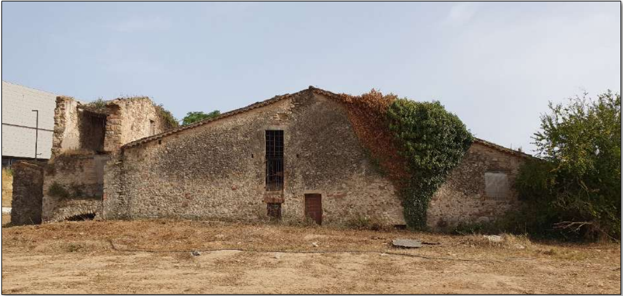
Imatge 220. Vista general façana nord de la masia
