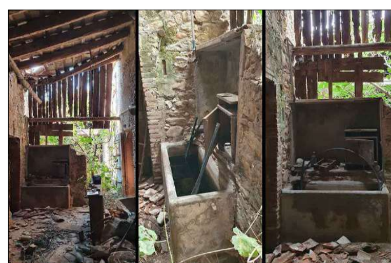
Al centre i la dreta es pot veure el safareig en detall. A l'esquerra l'accés cap a l'annex i a la dreta cap a la cort inaccessible 1. Un empostissat amb lames verticals de fusta, protegeixen el interior del garatge dels agents atmosfèrics.
