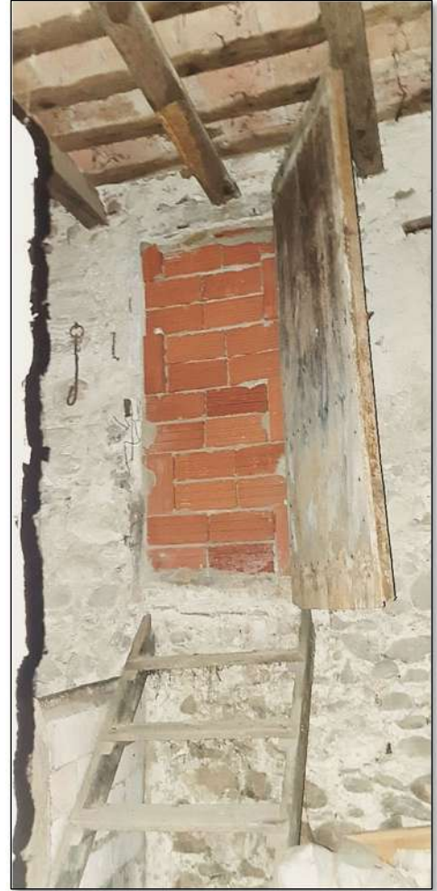
Imatge 33. Escala de fusta de dos muntants i 6 graons per accedir a la part exterior de darrera de la masia.
