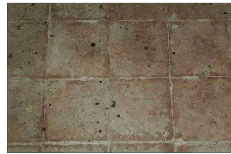
Paviment de tova d'argila cuita de 30x30cm col·locada, a junt seguit, amb morter de calç sobre llit de sorra d'anivellació.
