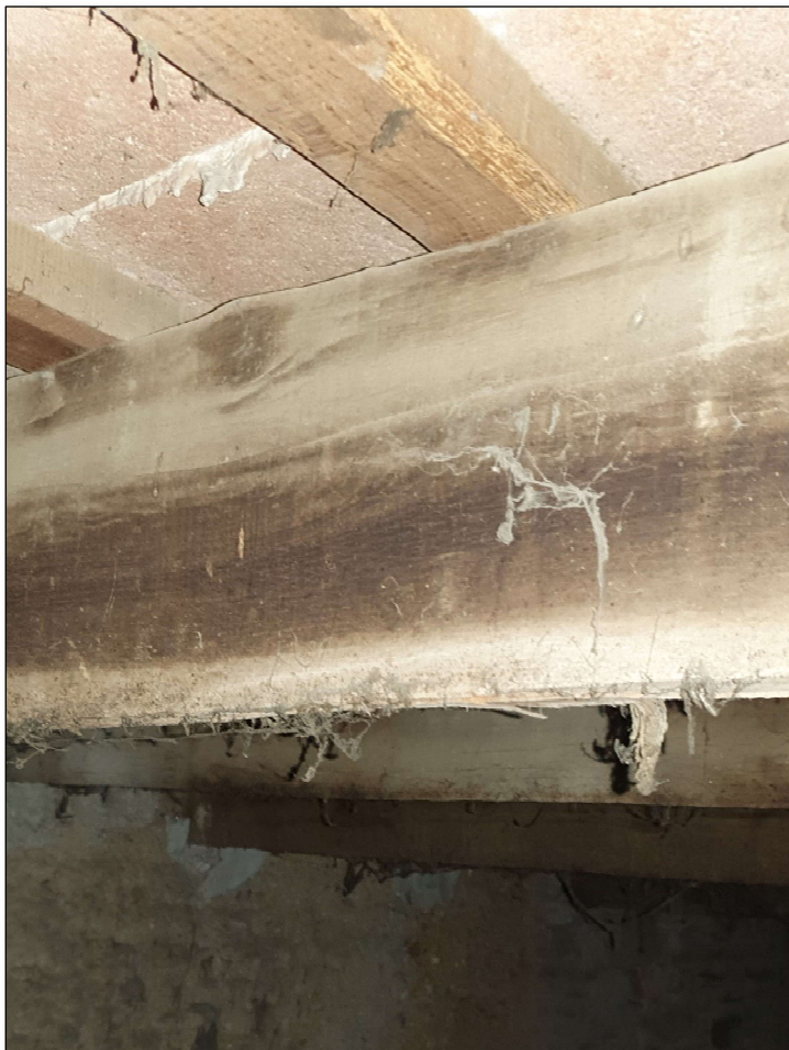
Imatge 143. Forjat de bigues de fusta rectangulars de secció variable i tauler de tova massissa de terra cuita de 30x30cms, a junt continu, col·locat sobre llates de fusta. Ubicació: Cort inaccessible 2.
