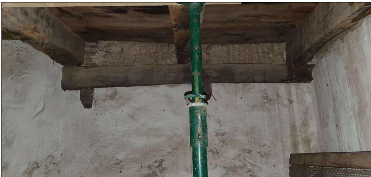
Imatge 90. Reforç amb biga travessera i mènsules de fusta per manca d'encastament de bigues de fusta en mur.
