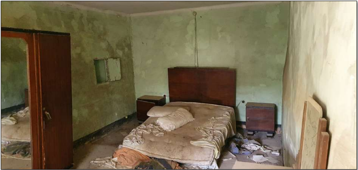
Imatge 66 Vista general de l'habitació 3.
