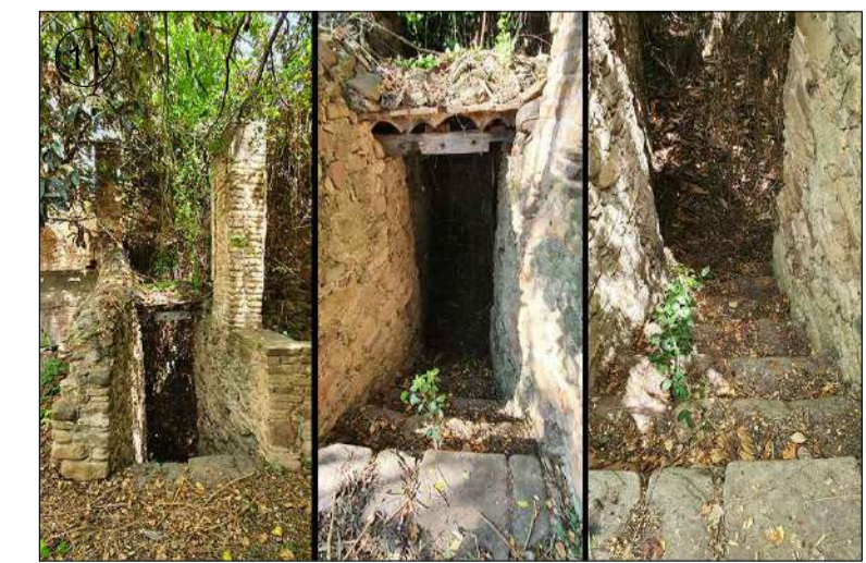
Accés cap a la mina. A l'esquerra, l'entrada d'accés; al mig, el pas d'entrada amb una petita marquesina; a la dreta l'escala que accedeix al nivell de la mina d'aigua.
