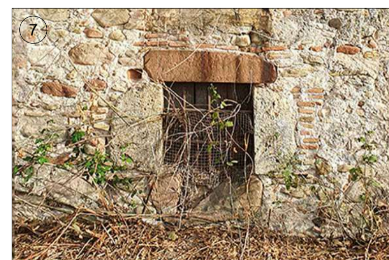
Finestra que pertany a la zona de celler. Està formada per una llinda plana de pedra i els brancals i l'escopidor també són de pedra.
