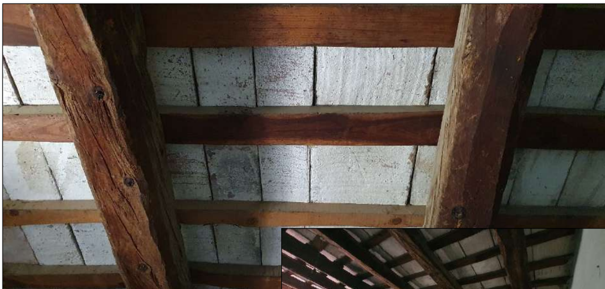
Imatge 158. Vista general i detall del sostre inclinat format per bigues (cavalls) i llates de fusta de secció rectangular amb tauler ceràmic de tova de 30x30cms i rajol de 15x30cms, ambdues de terra cuita, col·locades a junt seguit i encalades de color blanc. Ubicació: Habitació 4.
