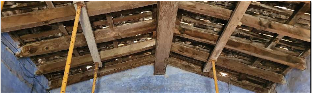
Imatge 154. Vista general de coberta al centre la jàssera carenada. Ubicada a la sala principal.
