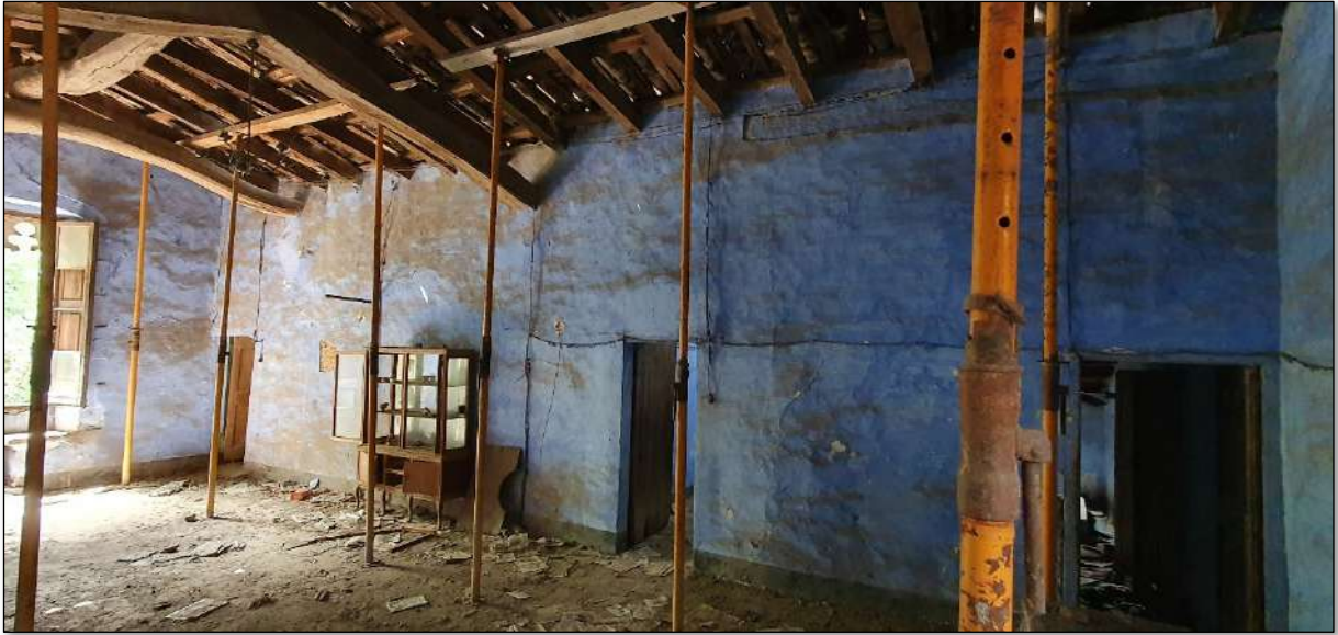
Imatge 224. Revestiment aplicat a base pintura a la calç en murs interiors. Ubicació: Sala principal de la planta primera.
