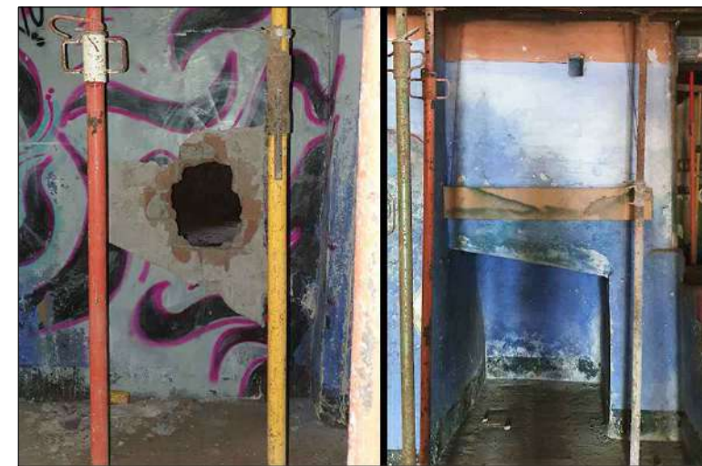
A l'esquerra, forat en l'envà que facilita les vistes cap al interior de la cort inaccessible 1; A la dreta, la rampa d'escala d'accés a planta primera, sobre aquesta l'espill o mirador per veure, des de la caixa d'escala, qui entrava a la sala
