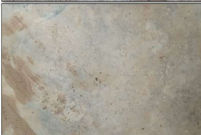
Imatge 192. Paviment de formigó ubicat en el celler.
