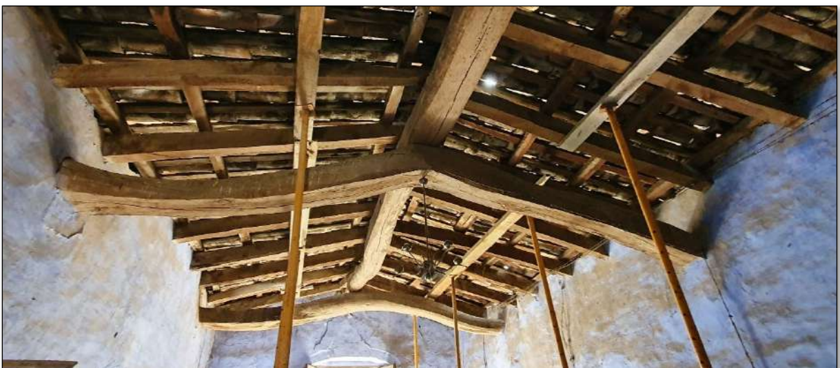
Imatge 155. Vista de encavallades de coberta. Ubicades a la sala principal.
