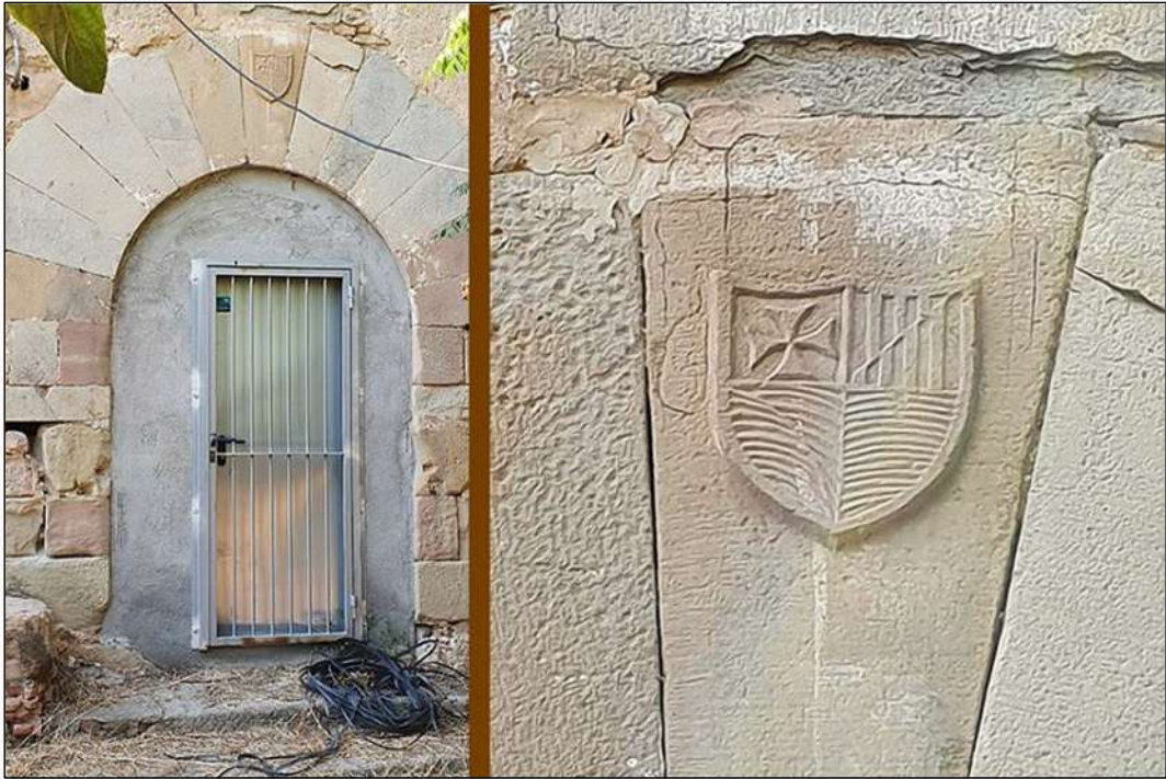
Imatge 15. Portal d'accés a la masia. Detall de l'escut.
