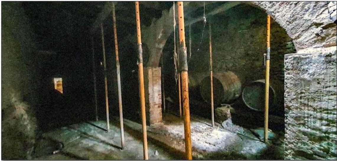
Imatge 29. Vista general del celler. Dos arcs de mig punt.
