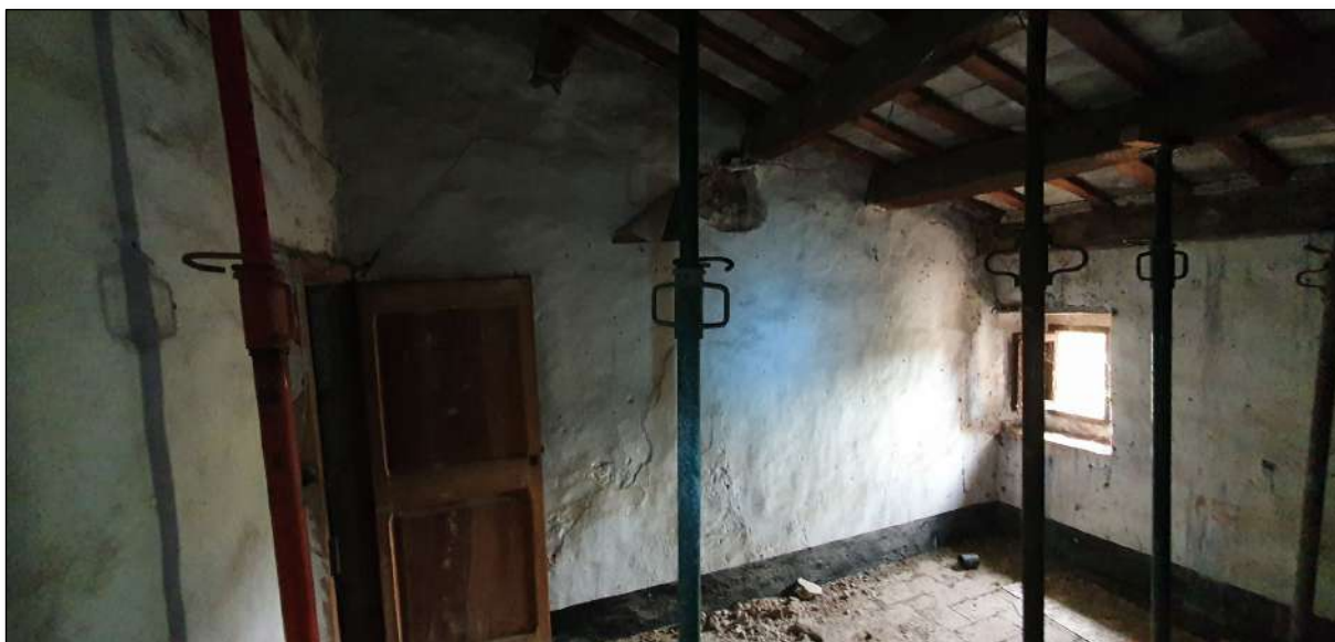
Imatge 91. Vista de l'habitació cap a la façana oest.
