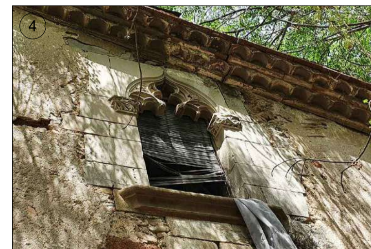
Finestra lateral dreta de la planta primera, amb arc conopial lobulat suportat per impostes amb relleus vegetals que recolzen sobre brancals de pedra amb secció quadrada sense cap tipus de decoració.
