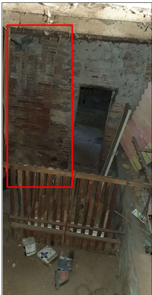
Imatge 244. Ubicació baixants de desguàs.
