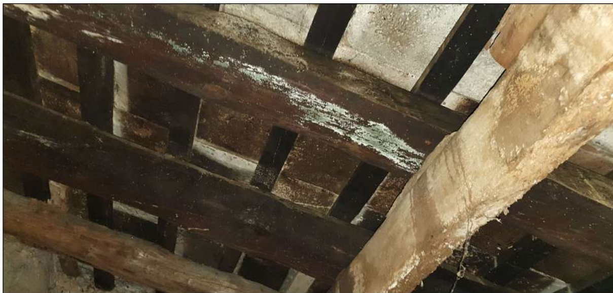
Imatge 170. Vista general del sostre inclinat format per bigues (cavalls) i llates de fusta de secció rectangular amb tauler ceràmic de tova de 30x30cms, col·locades a junt seguit i encalades de color blanc. Sobre una pàtina fina de sutge acumulat.
