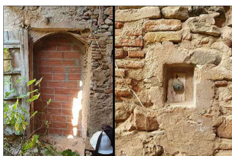
Porta, d'arc recte, tapiada per a accés a la cort inaccessible 1, destinada a establa pel bestiar. A la dreta, detall del interruptor encastat per encendre el llum.
