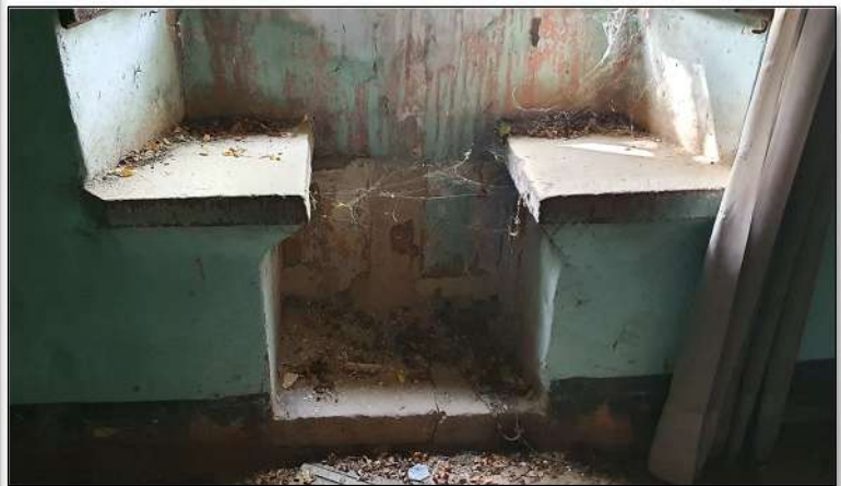
Imatge 61. Detall del festejador que es troba en bastant bon estat de conservació. L'espill de la finestra ha estat anul·lat.
