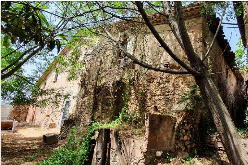
Imatge 215. Vista general de la façana principal. Façana sud.
