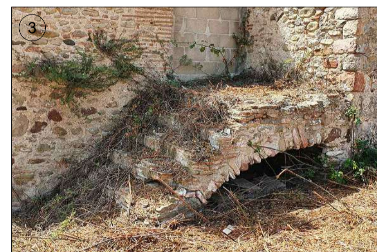
Formació d'escales amb volta a la catalana i grans amb maó massís, que donen accés a la planta inferior de la part posterior de la casa dels masovers.
