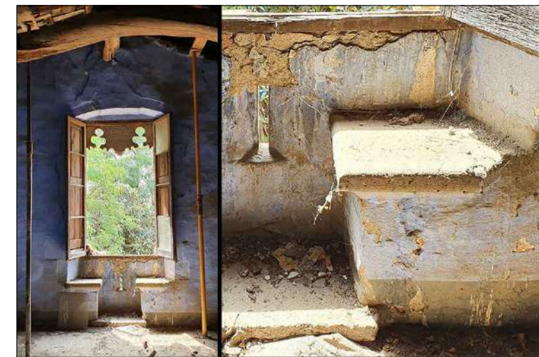
Finestra de la sala principal amb el festejador i espell a la seva part inferior. Es pot apreciar la llinda pel interior amb el doble arc trebolat. A la dreta detall del festejador i l'espell.
