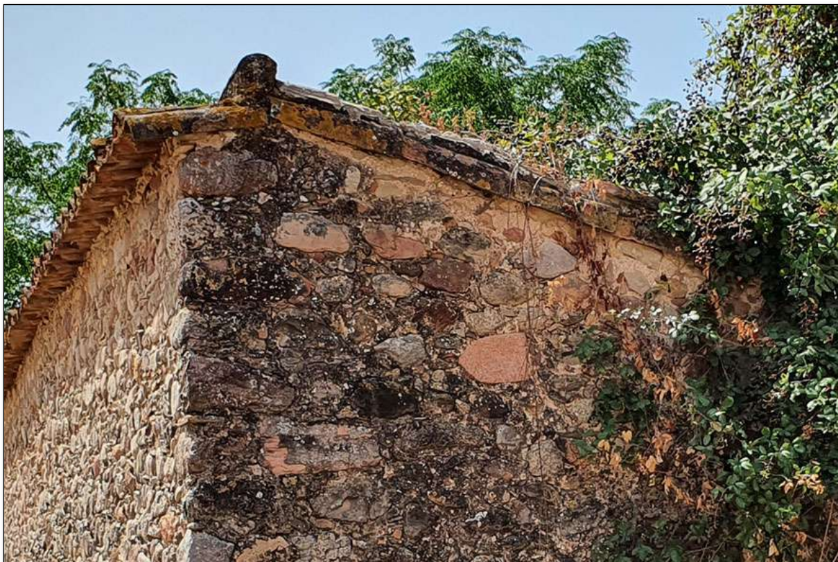
Imatge 183. Ràfec a plomada de mur amb teula capell. Ubicació: Façana nord. Cort casa masovers.
