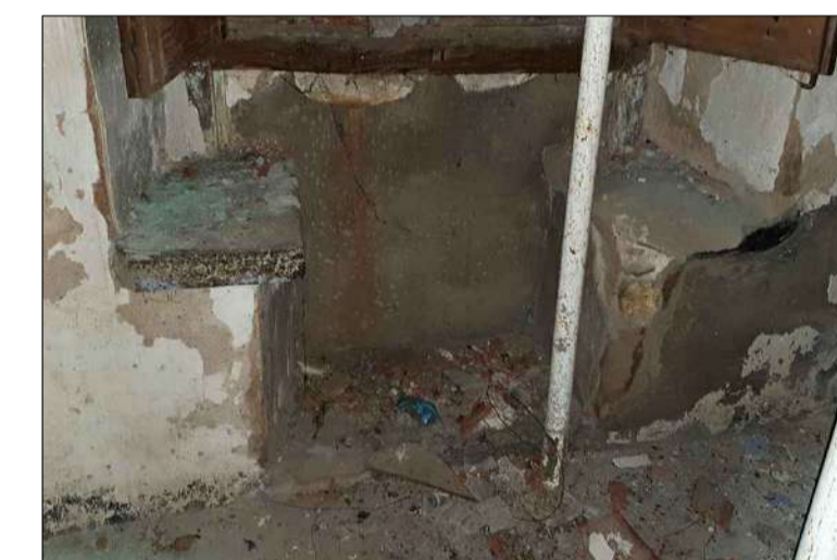
Detall del festejador existent molt deteriorat.
