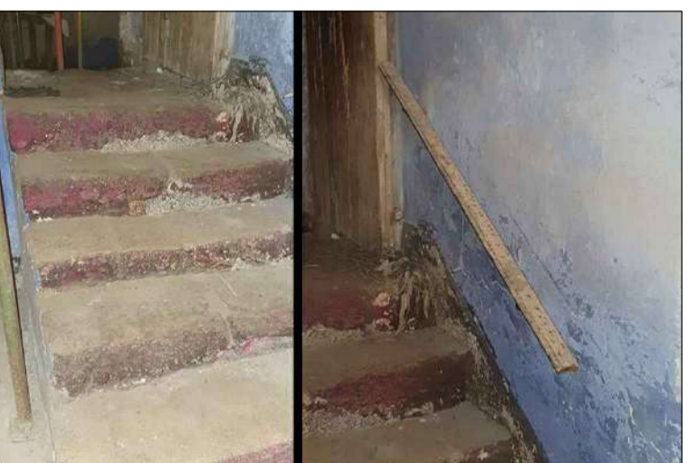
A l'esquerra detall de l'esglaonat recte de pedra A la dreta la barana de pipes de ferro.
