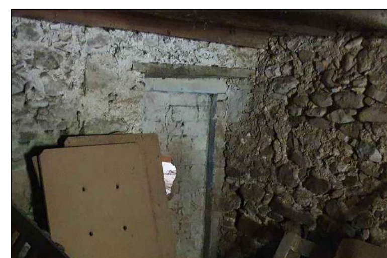
Porta tapiada per accés a l'espai des de la sala principal.
