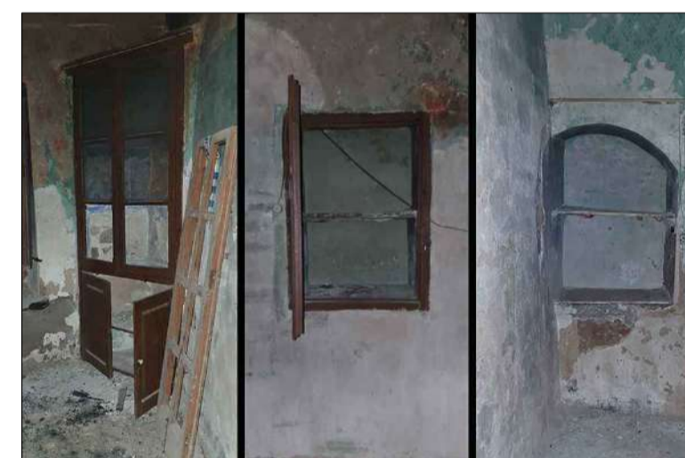
A l'esquerra un armari raconer amb lleixes. Al mig i a la dreta, fossats en els murs amb lleixa central. El fossat central disposa, amés a més, de porta i el de la dreta amb barra per a cortina.
