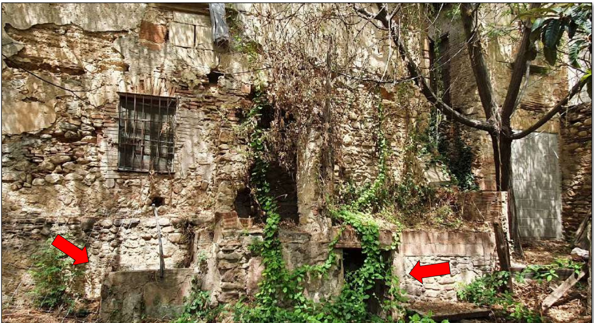
Imatge 236. Pou per extreure l'aigua. A l'esquerra un safareig fer refredar els pots de llet amb aigua freda. A la dreta el fossat per la ubicació del sistema de bombatge.
