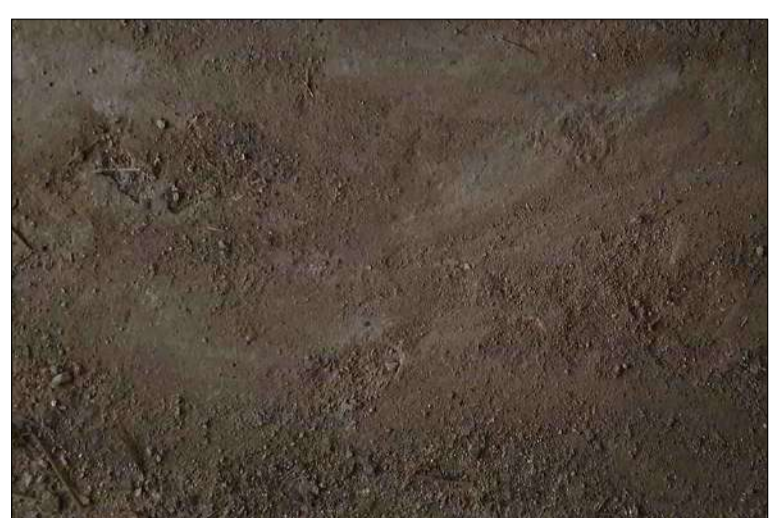
Paviment de morter barrejat amb calç amb acabat molt irregular.
