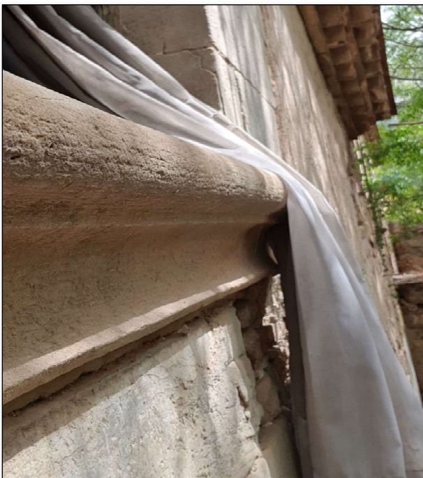
Imatge 64 Detall de les impostes amb les tres franges longitudinals i elements vegetals. La de la dreta està més malmesa.
