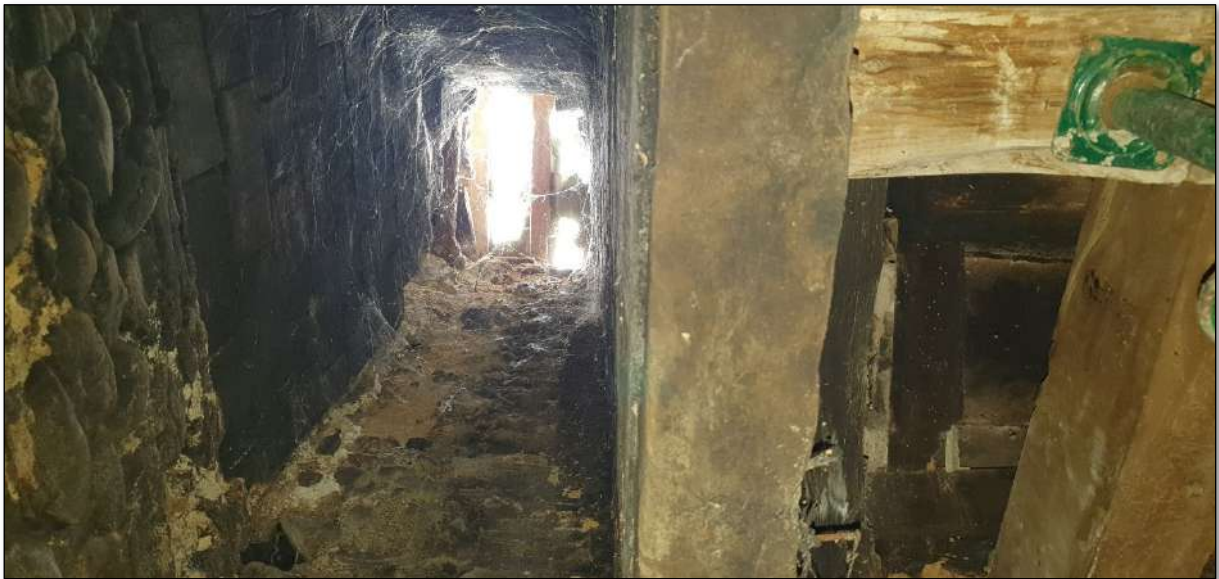
Imatge 249. A l'esquerra el tiratge de la llar de foc sense existència de curull. En el centre la llinda de la campana.
