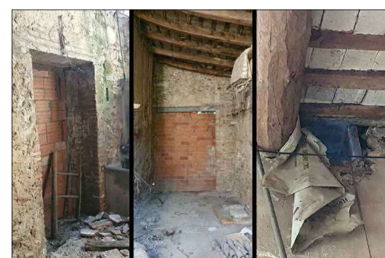
A l'esquerra, la porta amb llinda plana tapiada que dona accés a l'annex. Al centre l'obertura que comunica amb el barri. A la dreta l'obertura per a ventilació del bany de la planta primera
