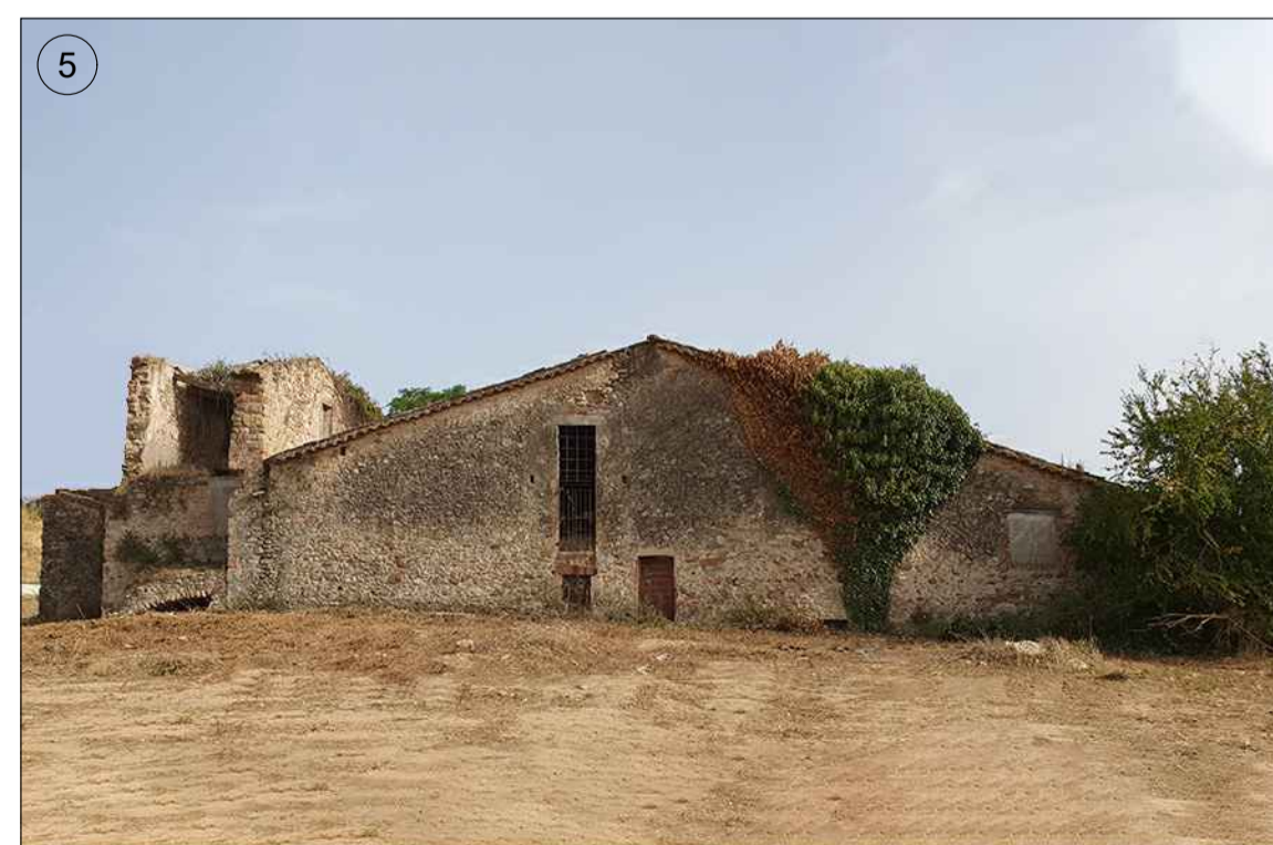
Vista general de la façana nord de la masia. A la part alta, sota el carener hi ha l'obertura que dona al graner i a la dreta una finestra tapiada que dona a un sotacoberta on s'ubiquen dipòsits d'aigua. A la part inferior, just a sota l'obertura del graner hi ha la finestra que dona al celler i, al costat, mig soterrada la porta d'accés al mateix. Al costat dreta hi ha una petita finestra del celler que està mig enterrada per acumulació de terres.
