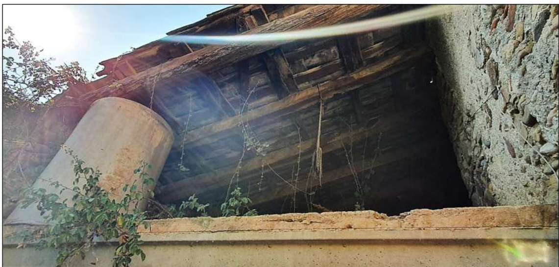
Imatge 37. Dipòsit de fibrociment per emmagatzematge d'aigua.
