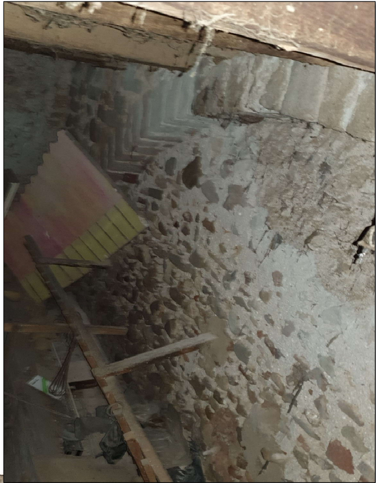
Imatge 115. Arcada confinada. Vista des de de cort inaccessible 2.
