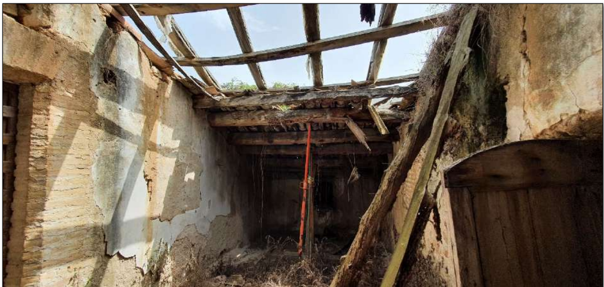
Imatge 222. Vista general del magatzem del graner. Els murs han perdut gran part del seu revestiment.
