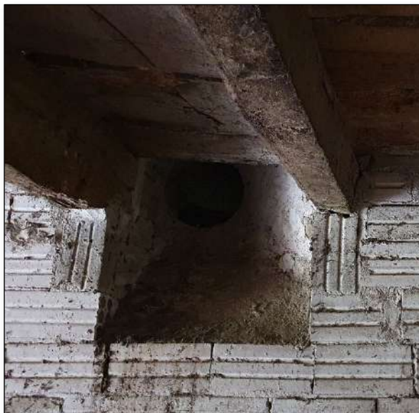
Imatge 250. Tub de formigó per a ventilació. A l'esquerra la boca del tub a la cort. A la dreta el recorregut del tub en el graner de la planta primera.
