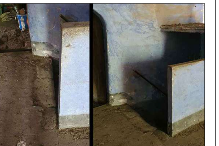
Arribada d'escala a la planta primera. L'escala està coberta amb un badalot que disposa de espills o miradors
