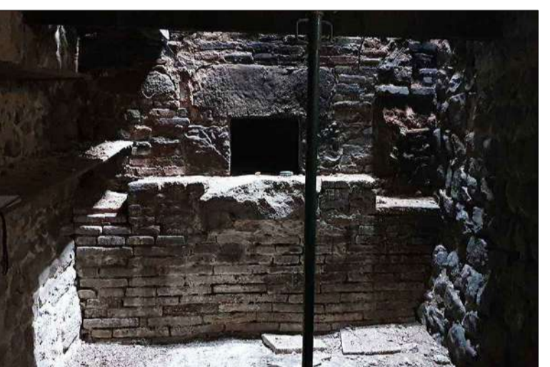
Forn de maó massís de 180cms de diàmetre interior. El fum sortia per la boca del forn i marxava per la campana que hi ha davant d'aquesta. La campana es existent tot i que està malmesa.
