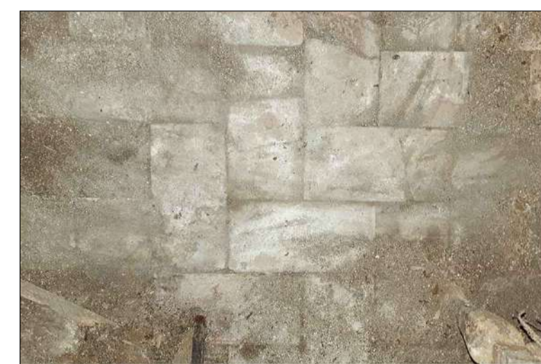
Paviment de maó massís d'argila cuita de 15x30cm col·locat, a la mescla o espina, amb morter de calç sobre llit de sorra d'anivellació.
