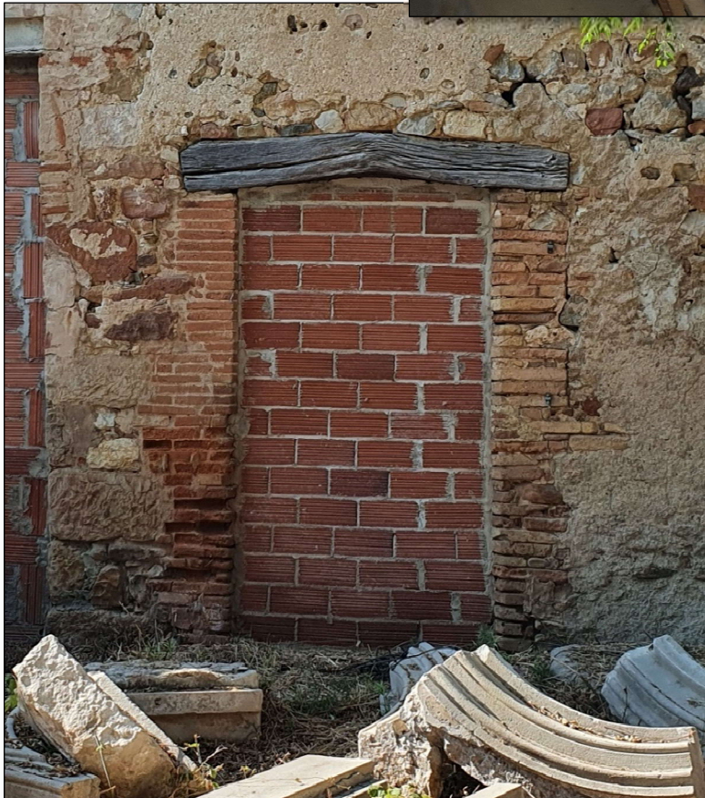
Imatge 115. Realització de cantonades i brancals d'obertures.
