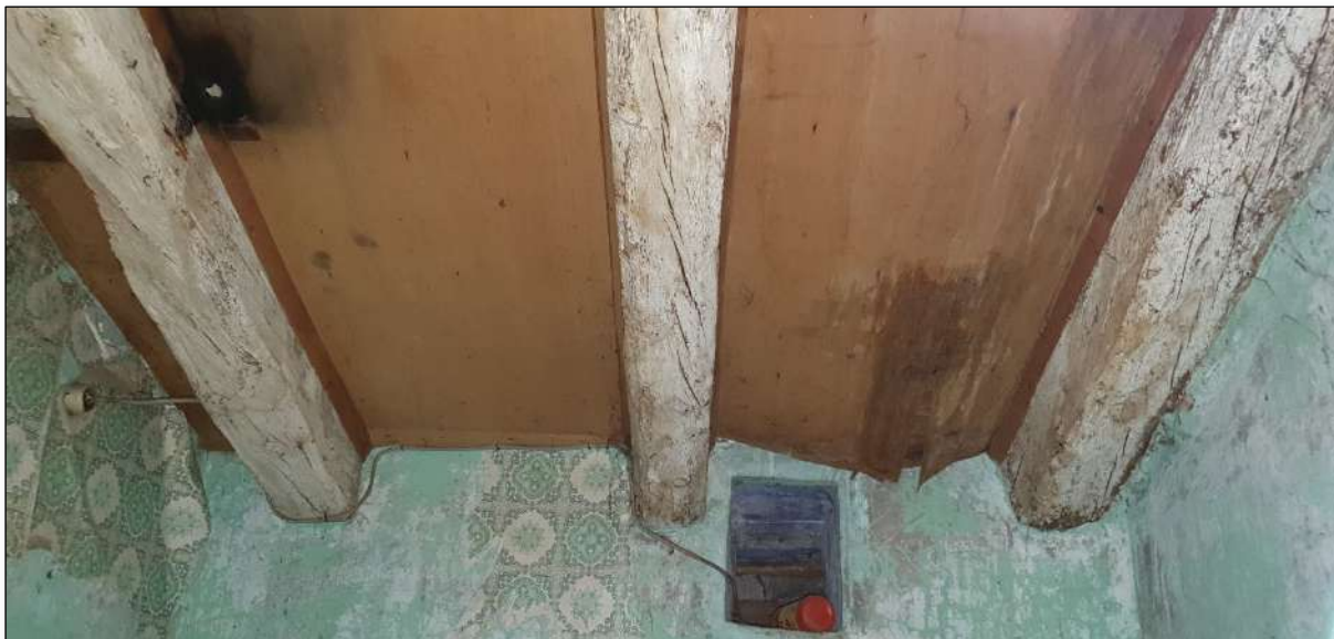
Imatge 156. Embellidor d'entrebigat realitzat amb tauler de fusta entre cavalls de coberta. Ubicació: Bany.
