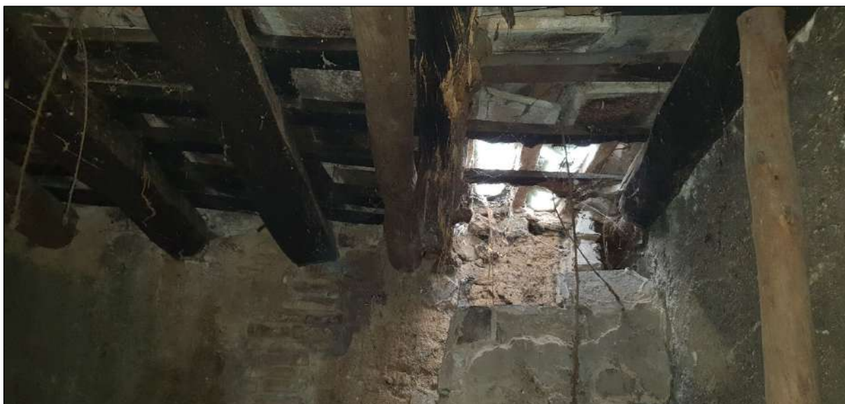
Imatge 122. Mur de la cambra calenta en la zona del tiratge del forn de la planta baixa.
