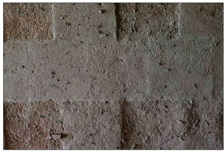
Paviment de tova d'argila cuita de 30x30cm col·locada a trencajunts, amb morter de calç sobre llit de sorra d'anivellació.
