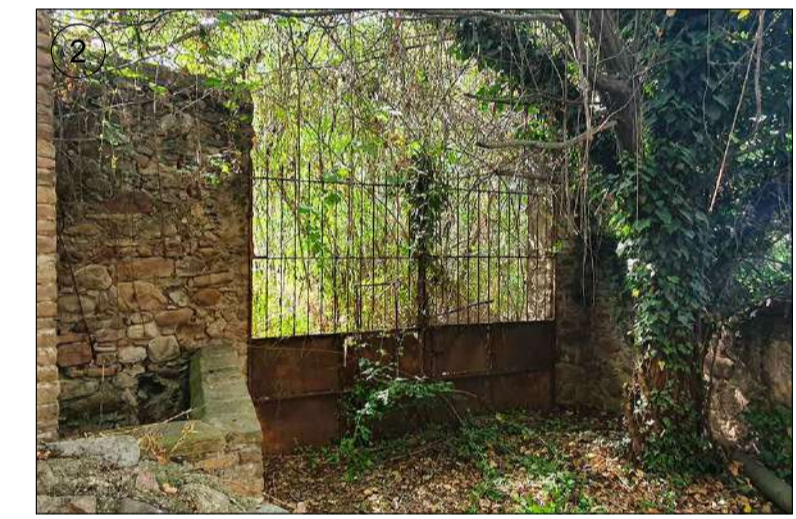
Vista interior d'un altre accés del barri. La porta és de doble fulla feta amb barres verticals cilíndriques de ferro acabades, en la seva part superior, amb punta de fletxa.
