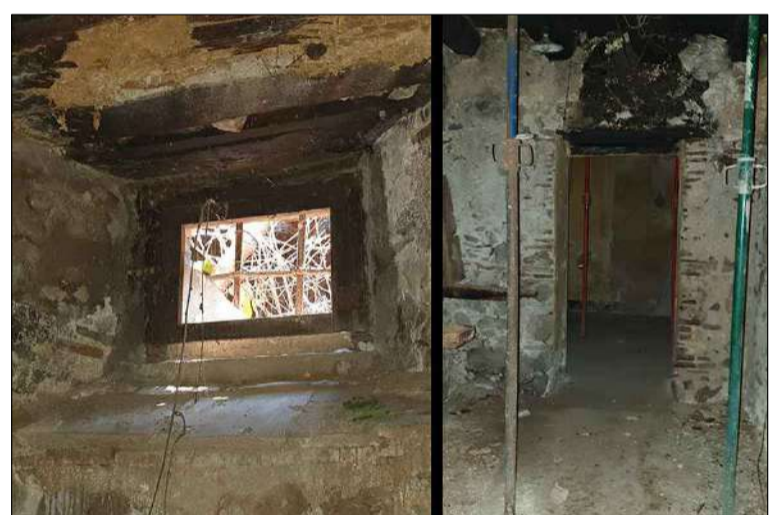
A la dreta porta d'accés a l'obrador des de la cuina. A l'esquerra finestra amb ample alt i llinda plana de fusta i una reixa de forja.
