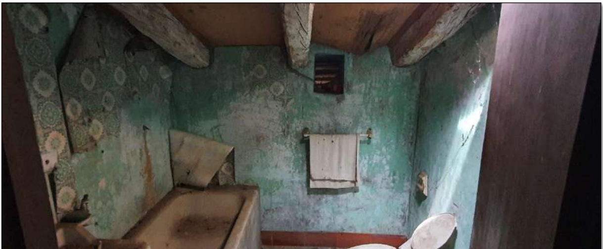
Imatge 226. Revestiment a base de paper decoratiu en murs interiors. Ubicació: Bany.
