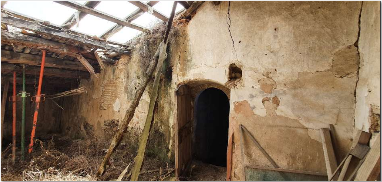
Imatge 102. Mur amb la porta d'accés cap el magatzem. Vista des del magatzem.
