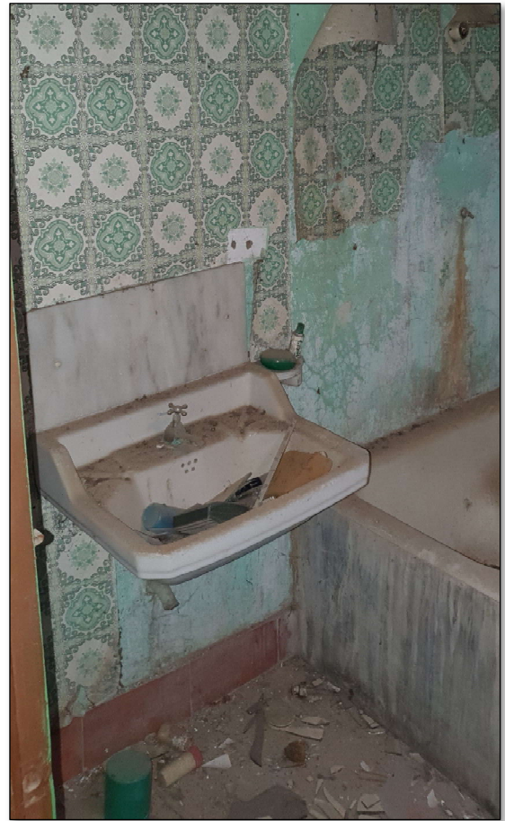
Imatge 80. Pica rentamans, amb aixeta de disc per aigua freda.
