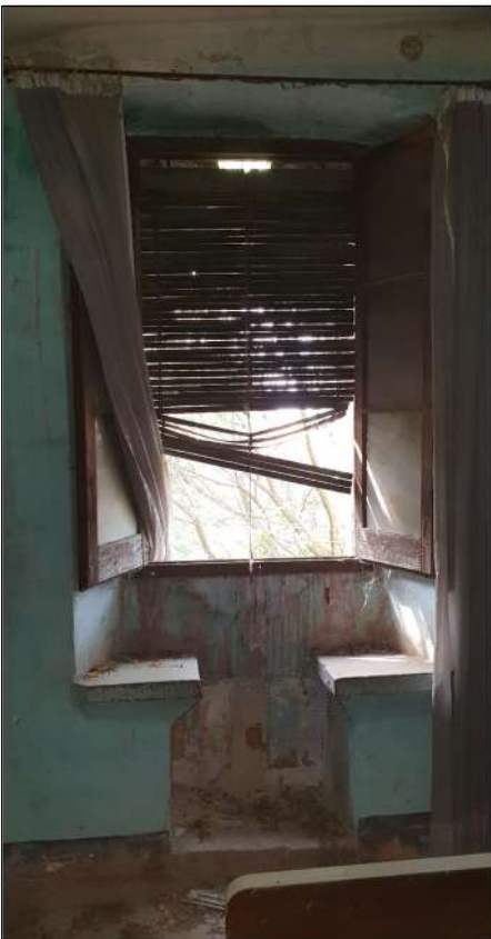
Imatge 60. Finestra de fusta de doble fulla practicable amb festejador. Entre la persiana s'aprecia la llinda decorada. Encara disposa de la cortina i persiana de corda.
