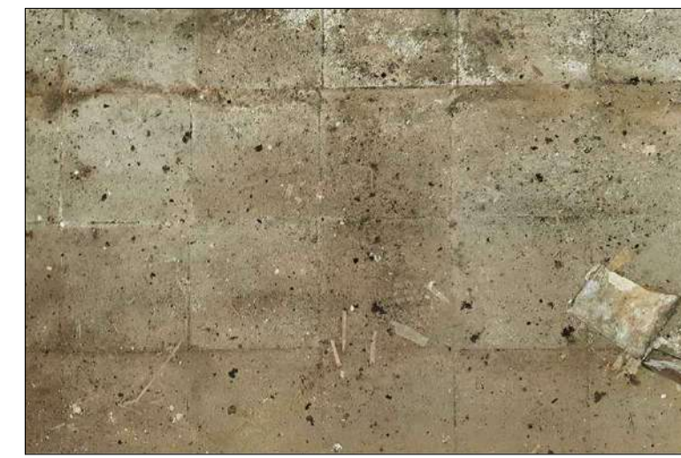
Paviment de tova d'argila cuita de 25x25cm col·locada, a junt seguit, amb morter de calç sobre llit de sorra d'anivellació.
