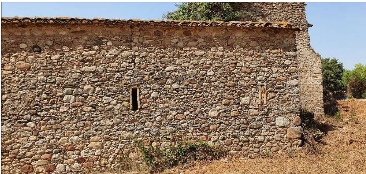
Imatge 111. Mur de paredat.
