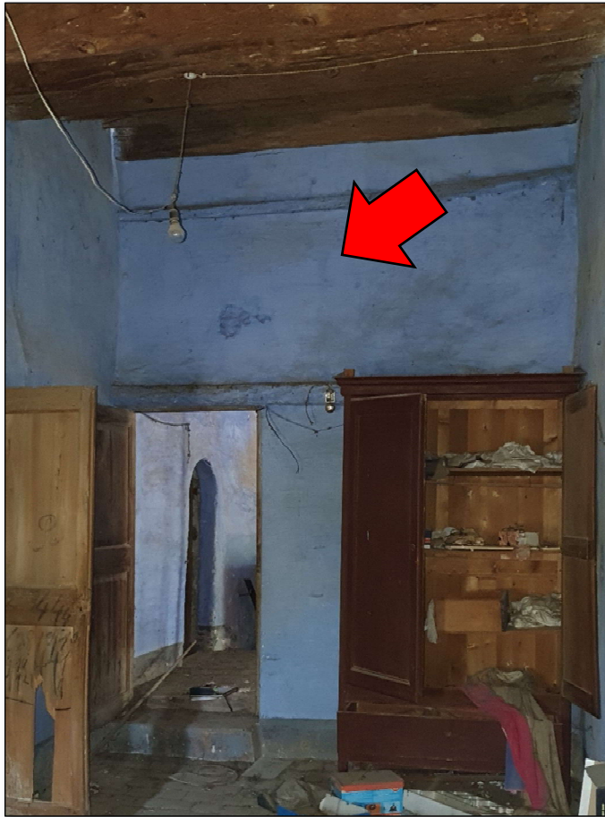
Imatge 126. Mur de 15cms de gruix de tancament de l'habitació 5. A la part superior hi ha una jàssera on recolzen les bigues de la coberta inclinada de la sala,
