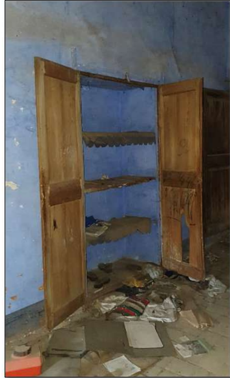
Imatge 87. Armari encastat en el mur amb prestatges intermedis.
