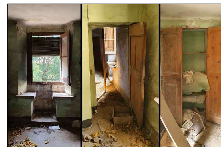
D'esquerra a dreta: La finestra amb doble fulla i porticons interiors, una persiana de corda i a la part inferior el festejador. En el centre, la porta d'accés a l'habitació 3. A la dreta, l'armari encastat en el mur.
