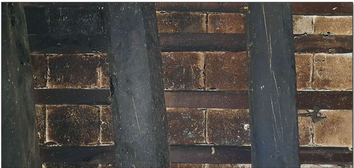
Imatge 141. Forjat de bigues de fusta arrodonida-carejada de secció variable i tauler de tova massissa de terra cuita de 30x30cms, a junt continu, col·locat sobre llatges de fusta. Ubicació: Obrador.
