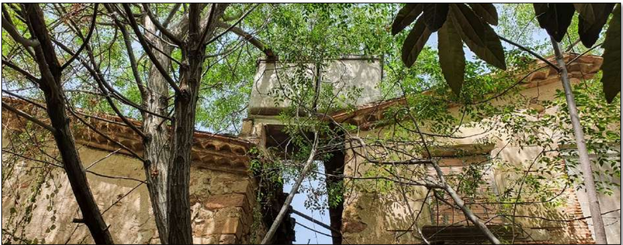
Imatge 238. Dipòsits per emmagatzematge d'aigua sobre coberta.
