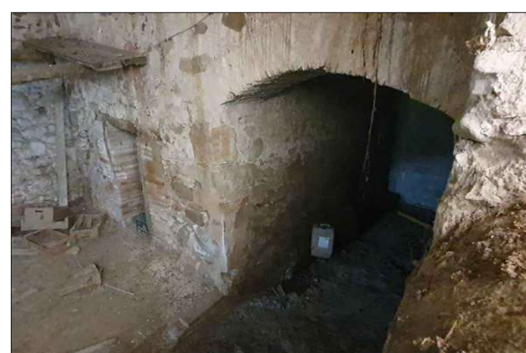
Accessos existents des del barri. El de l'esquerra amb llinda plana i el de la dreta amb arc recte.
