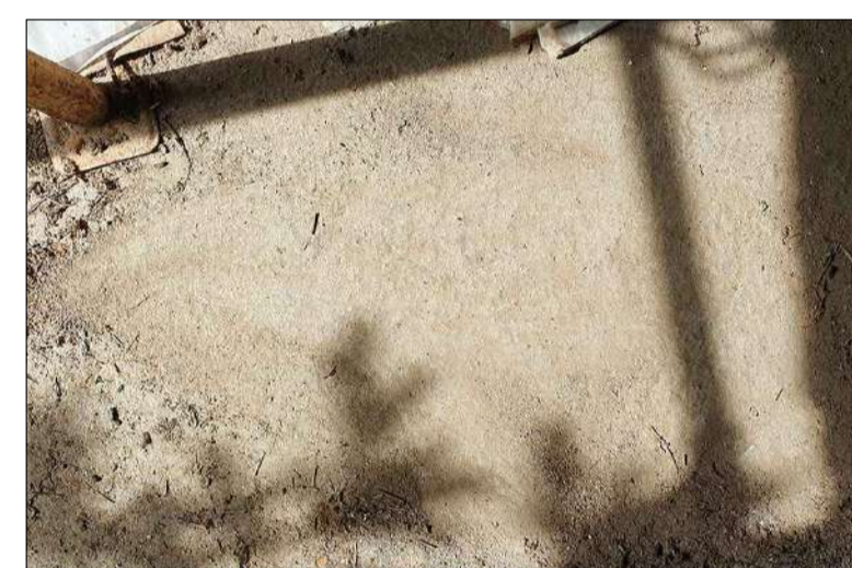
Paviment de morter barrejat amb calç amb acabat irregular.
