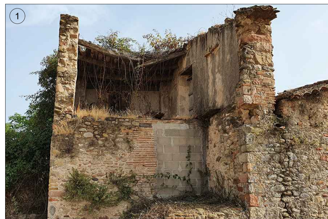
Vista general de la part posterior de la casa dels masovers que comunicava, per l'obertura de la planta superior, amb el graner de la masia, concretament a la zona més nord-est de la masia. Aquesta zona està parcialment enderrocada. Hi manca la coberta inclinada, deixant a ull nu l'interior del pis superior. Els murs estan fets amb maçoneria i es poden veure brancals de maó massís en la planta inferior. L'accés tapiat de planta inferior segurament comunica amb l'espai de la tina, on es premsava el vi, i aquest amb el celler de l'edifici principal.
