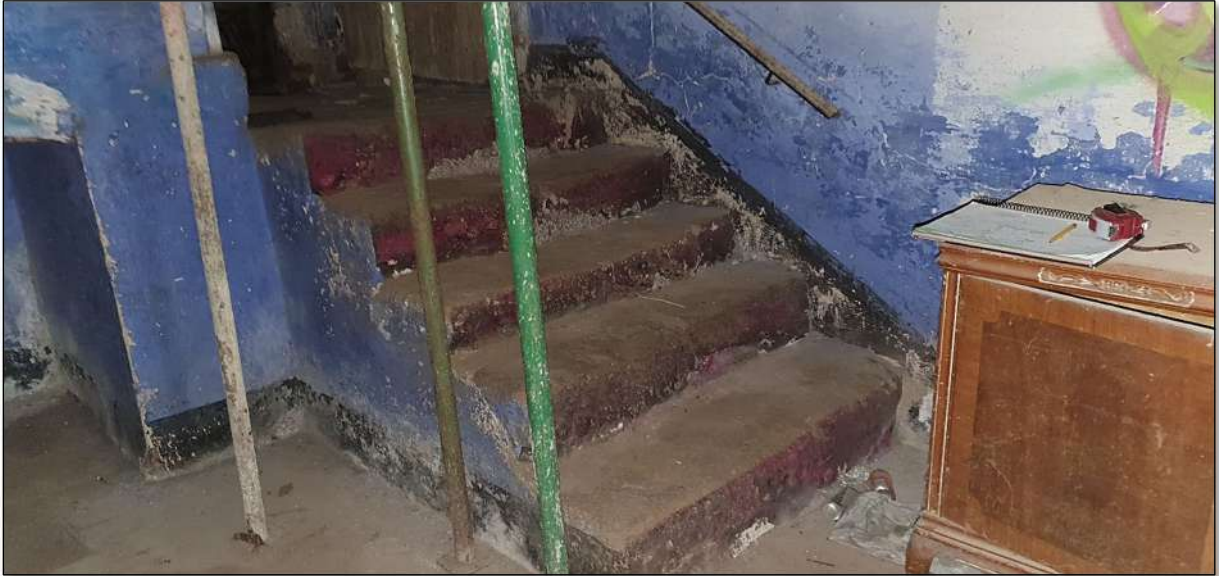
Imatge 41. Primer tram d'escala del nucli de comunicació amb la planta primera.
