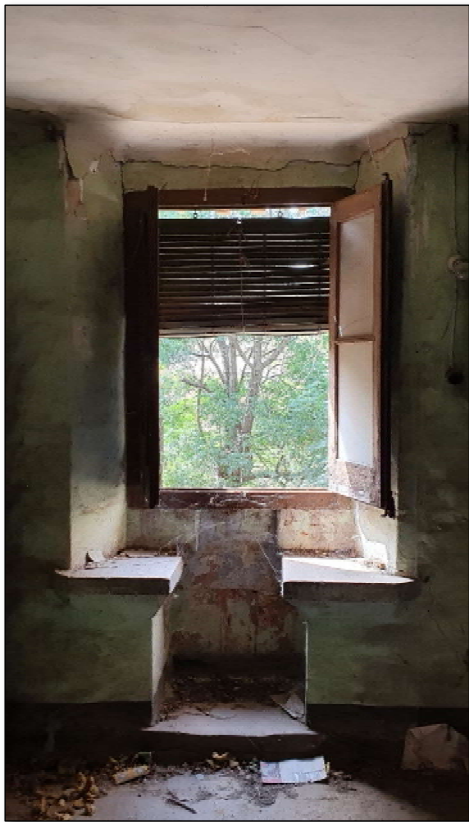
Imatge 70. Finestra de fusta de doble fulla practicable amb festejador. Es pot veure la llinda decorada sobre la persiana de corda.
