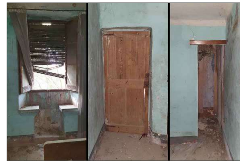
A l'esquerra hi ha la finestra amb festejador. En el centre la porta de l'habitació i, a la dreta, el pas cap al recambro.
