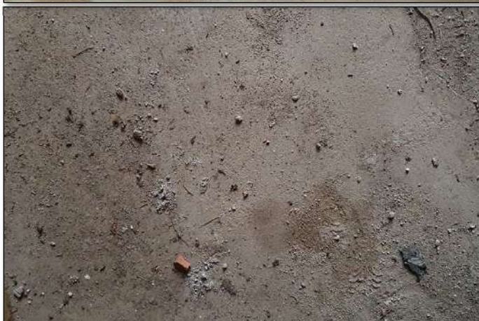
Imatge 193. Paviment de formigó ubicat en el garatge.
