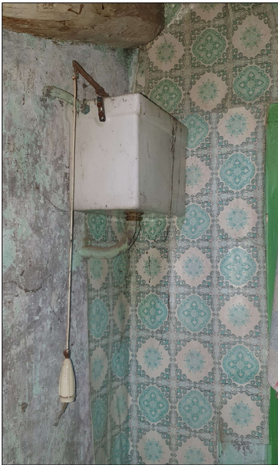
Imatge 79. Cisterna elevada ubicada darrera la porta.
