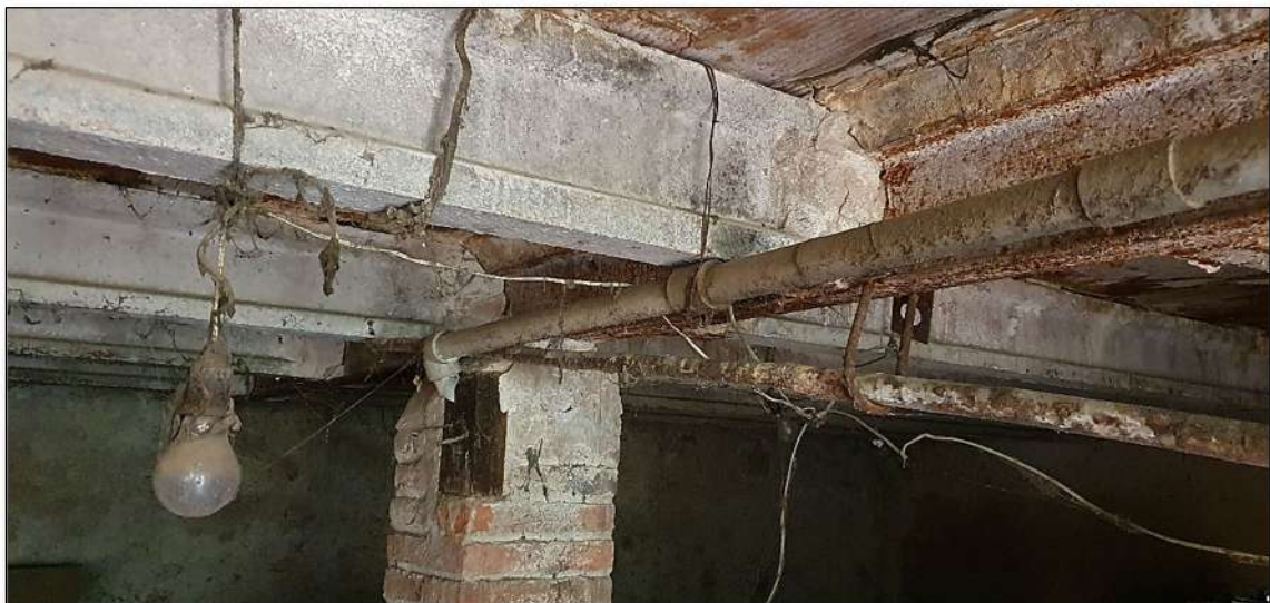
Imatge 36. Sistema malmès de subministrament d'aigua per el bestiar.
