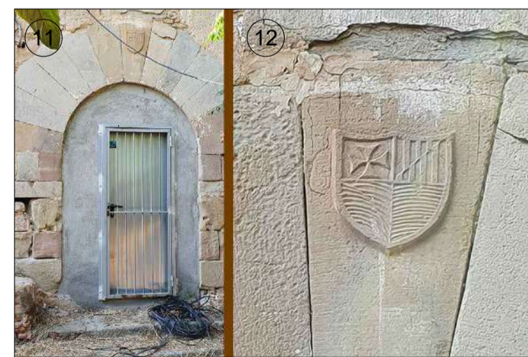
A l'esquerra el portal d'entrada principal de la masia amb arc de mig punt amb tretze dovelles de pedra calcària. A la dreta, detall de l'escut que es troba a la clau de l'arc de mig punt. Els salmers descansen sobre els brancals de pedra de secció quadrada.
