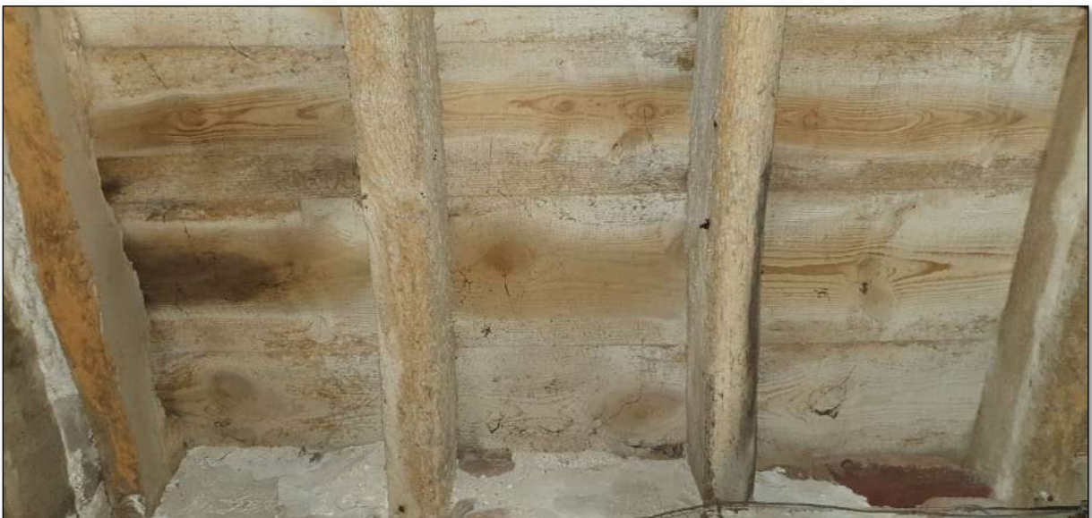
Imatge 133. Forjat horitzontal de bigues de fusta amb tauler de fusta del pas cap al celler.
