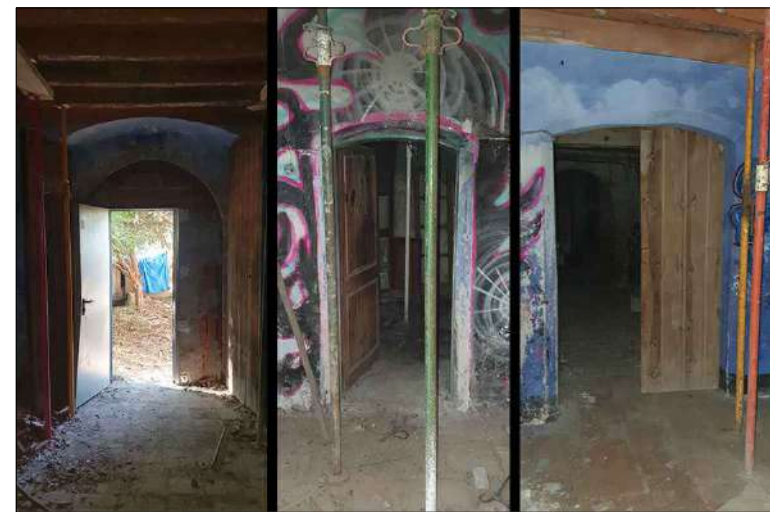
Diferents portes d'accés a espais. A l'esquerra, l'accés des del barri amb arc de mig punt; Al centre, cap el menjador i la dreta la porta cap el celler, aquestes amb l'arc capçalat de sant Antoni.
