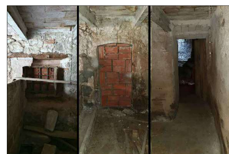
A l'esquerra, la finestra de la cort, tapiada i amb una reixa de forja. Al centre la porta tapiada de façana oest. A la dreta la porta que comunica amb el celler.
