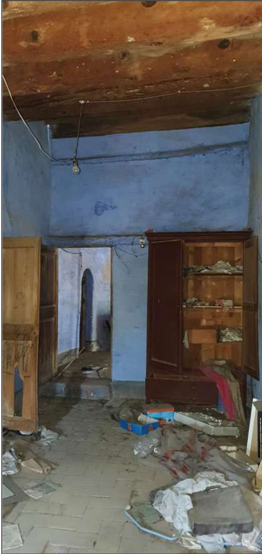
Imatge 86. Vista de l'accés i la gran alçada de sostre .
