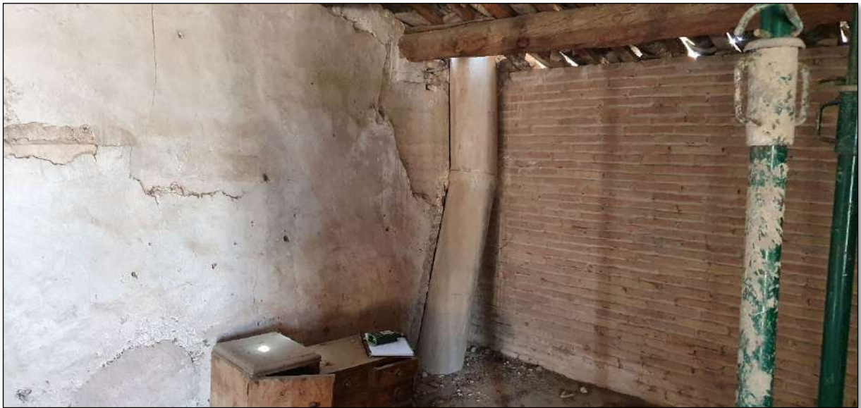
Imatge 124. Mur, de 15cms de gruix, per a separació del graner i la zona de dipòsits realitzat amb maó massís de tres quarts.
