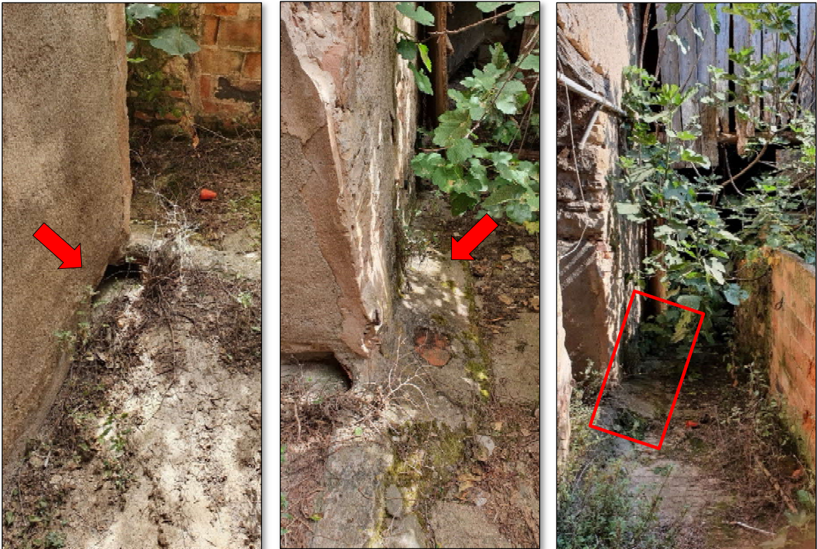
Imatge 243. A l'esquerra, el punt de desguàs. Al centre, la canalització pel costat de la rampa. A la dreta, la rampa per on baixa la canalització tapada.
