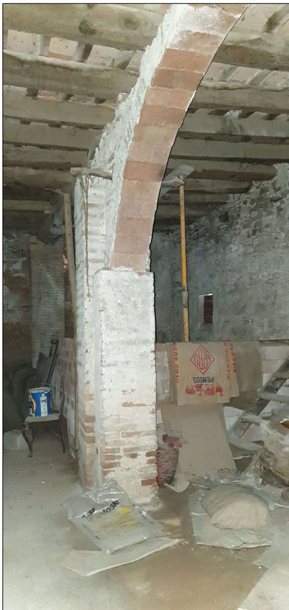
Imatge 128. Arcs de mig punt i pilars de maó massís en el celler.
