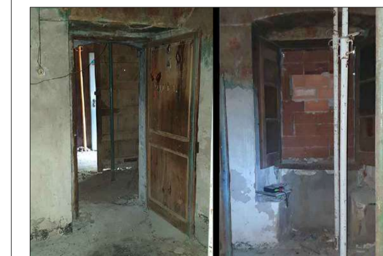
A l'esquerra, l'arc capçalat de sant Antoni que hi ha a l'accés cap a la sala principal. A la dreta, la finestra que dona al barri amb un arc capçalat de Montpeller i a la part inferior el festejador.
