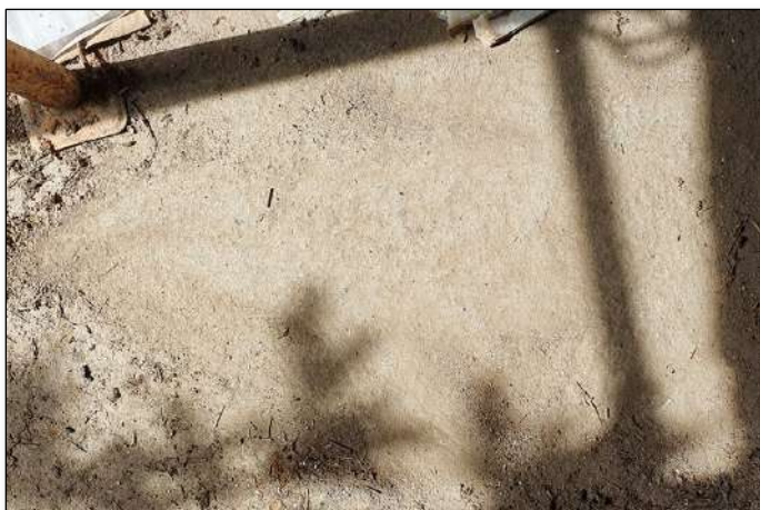
Imatge 190. Paviment de morter barrejat amb calç ubicat en la cort. (Cel obert)
