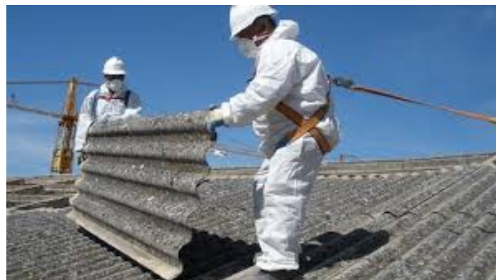
Menatge de les plaques en parelles i amb dispositius anti-caiguda per treballs en alçada
