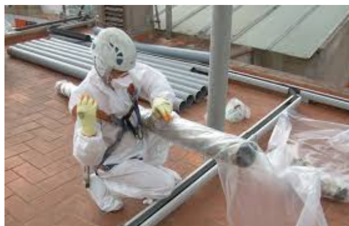
Encapsulat dels MCA amb bosses d'un sol ús
